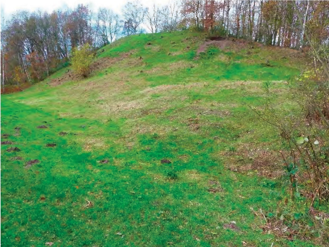
Abbildung 10: Maßnahmenstandort 7 (im Winter 2011/2012 freigelegt) mit Anzeichen fortschreitender Vergrasung
