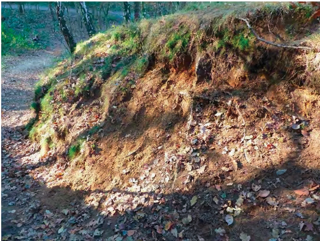
Abbildung 4: Abbruchkanten im Hohlweg der Böschung (Maßnahmenvorschlag 1, siehe Abbildung 3), eine von zwei im Gebiet noch erhaltenen derartigen Strukturen
