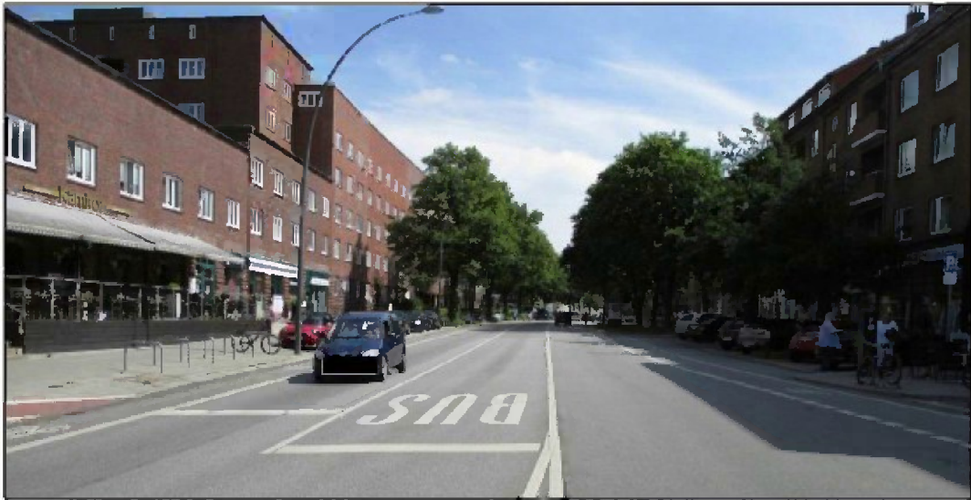
An der LSA Fuhsbüttler Straße/Alte Wöhr wurde in Fahrtrichtung Norden ein etwa 140m langer Bussonderfahrstreifen eingerichtet, welcher den Bussen das Vorbeifahren am Rückstau bis zur Haltelinie ermöglicht.
