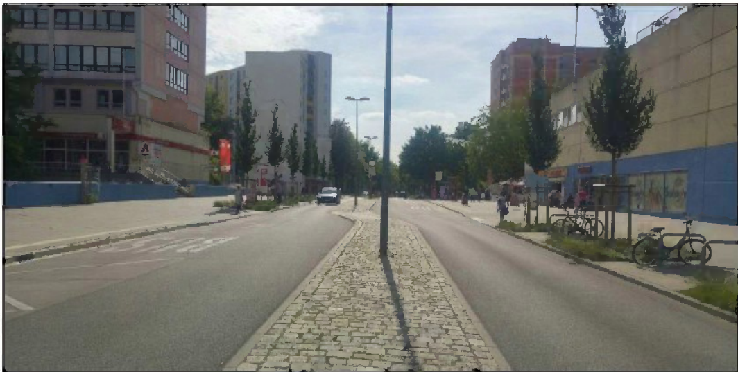
An der Haltestelle EKZ Steilshoop gibt es nun einen Mittelstreifen für eine sichere Querung des Fußgängerverkehrs.
