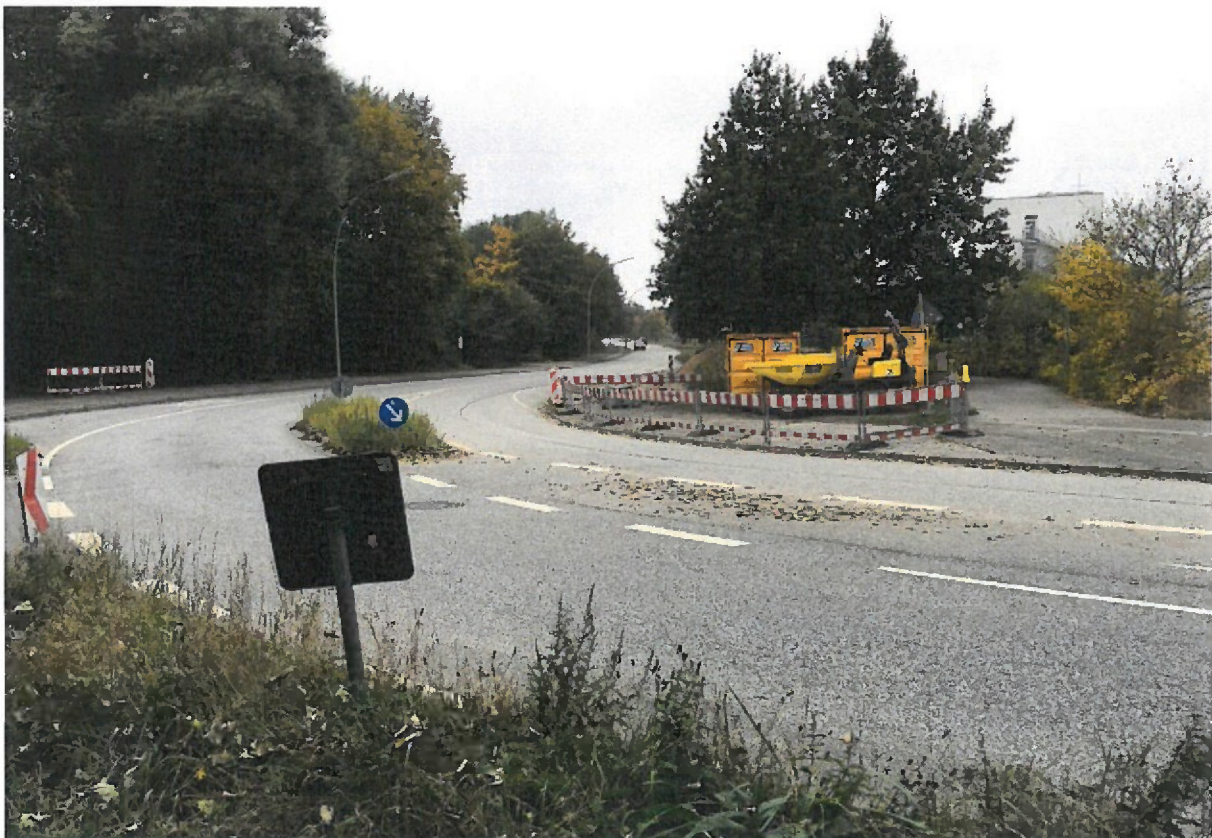
Abbildung 7-2: Vorhandener Ausbau "Rungedamm"
