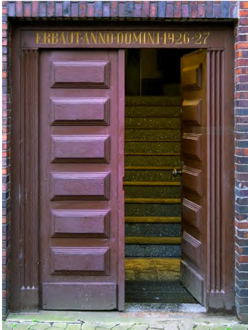
Abb. 30: Eingangstür neues Sudhaus
