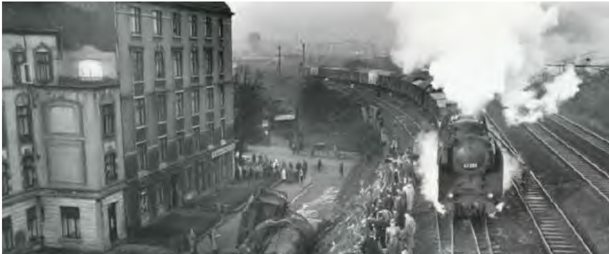
Abb. 11: Foto Ecke Harkortstraße / Holtenustraße ca. 1950
