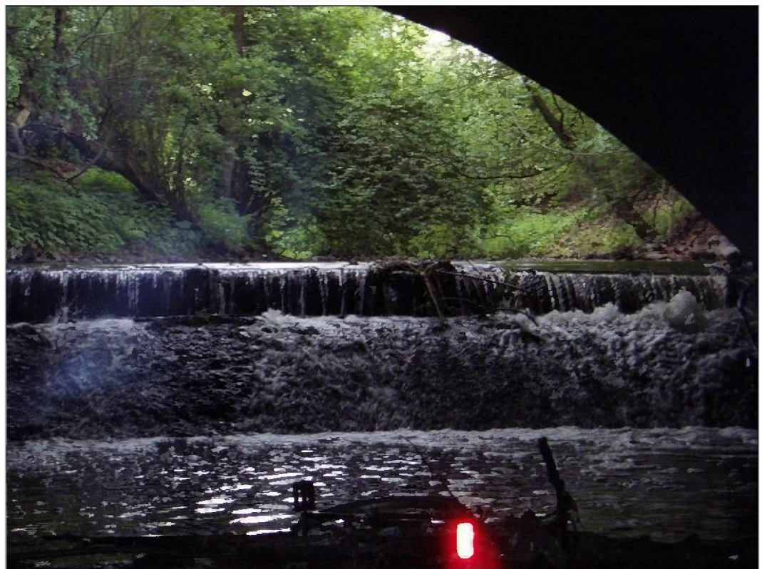
Abbildung 2: Gewässerabschnitte des Eilbekkanals (oben: oberhalb des Kuhmühlenteiches, unten: Wehr an der Friedrichsberger Straße)
