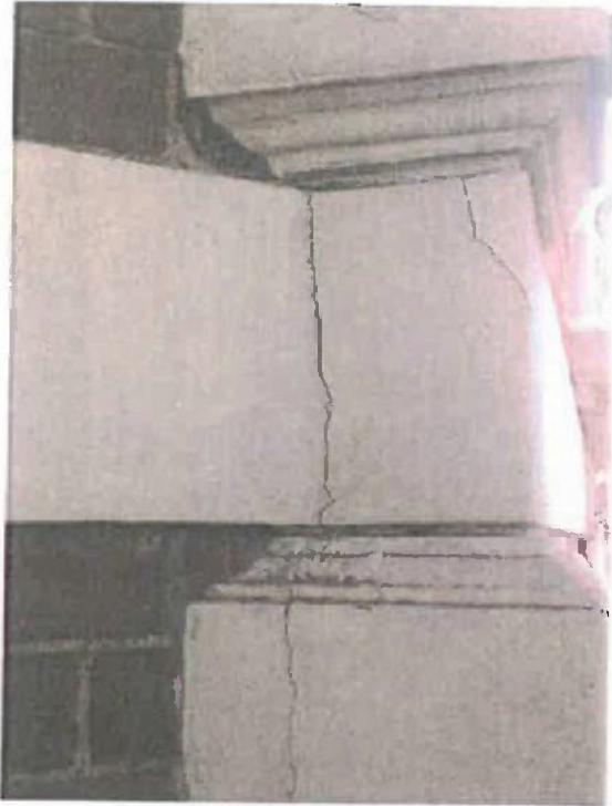
Bild 7 abgeplatztes Mauerwerk
