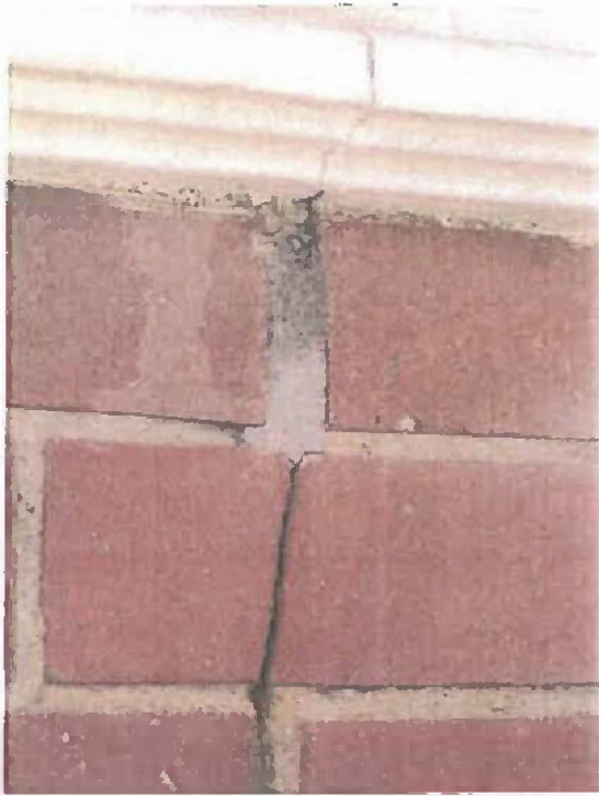
Bild 5 gerissenes Mauerwerk infolge Stahlkorrosion
