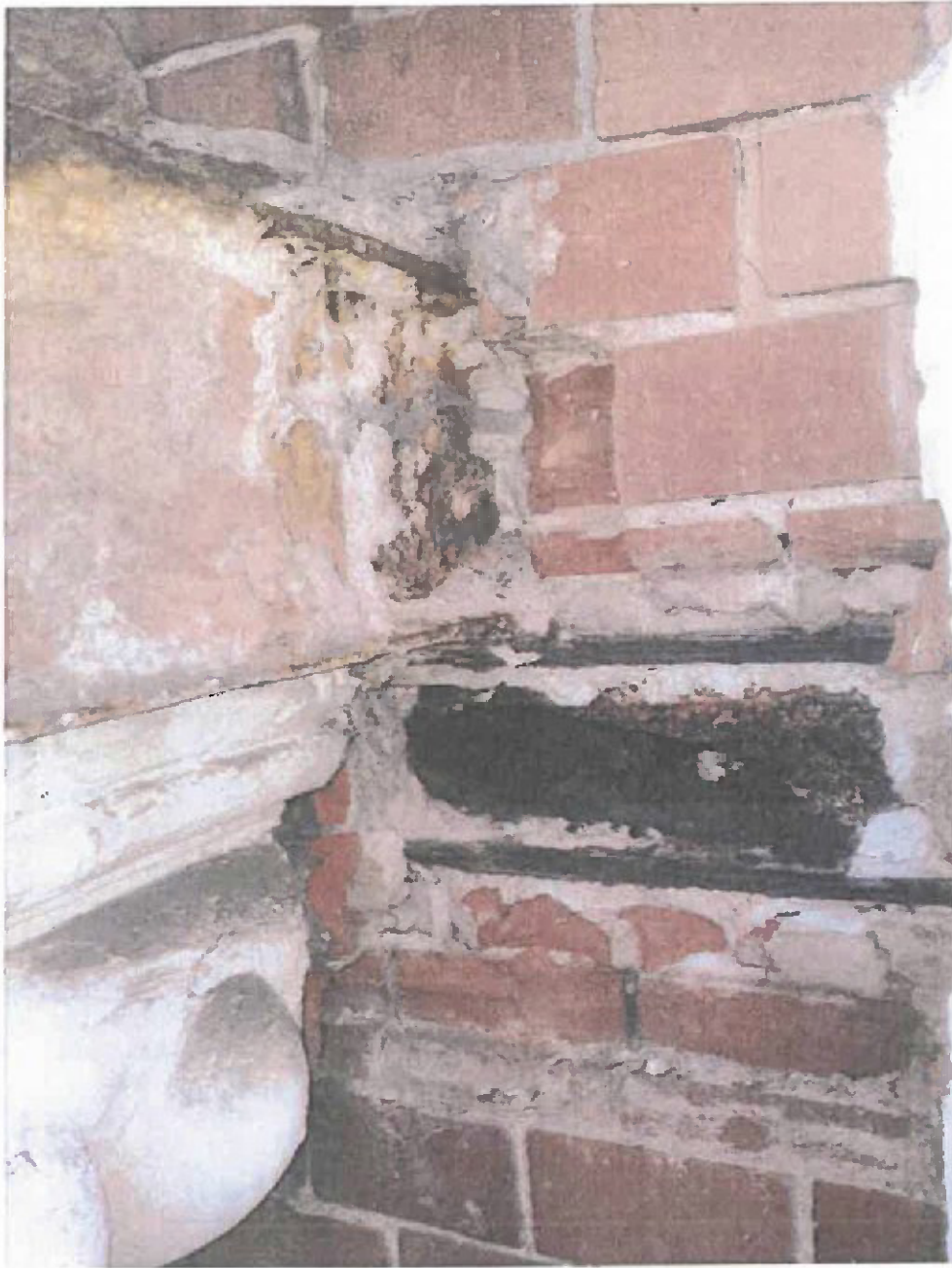
Bild 9 Anschluss Balkenträger an das Mauerwerk mit Stahlschwelle Untergehängte Stuckelemente
