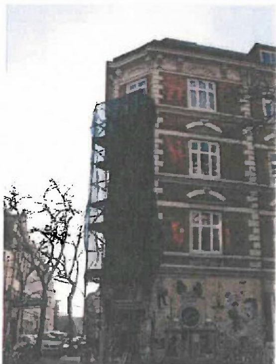
Bild 2 Eingerüstete Balkonanlage vor der Friedensallee
