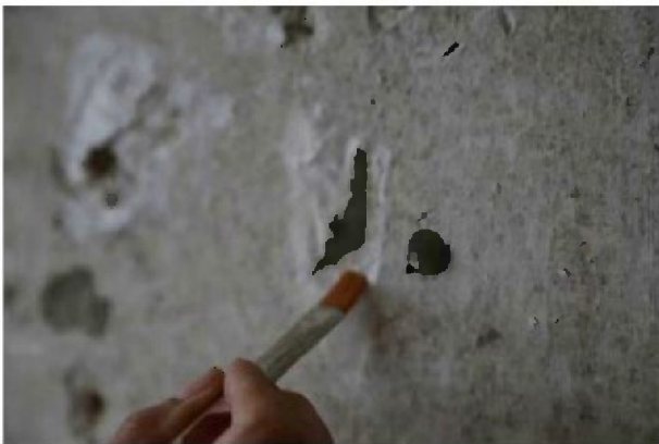
Abb. 11: Raum 04b, Wiederanbringung der Tapetenfragmente
