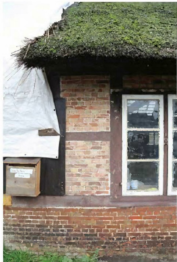
Abb. 4: Bearbeitete Gefache
