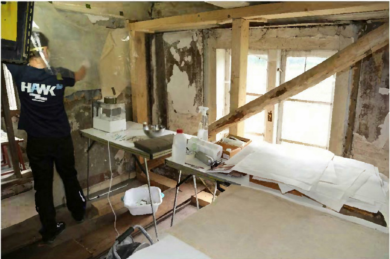
Abb. 8: Abnahme einer Tapetenbahn in Raum 05
