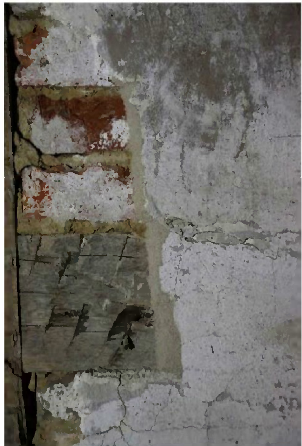
Abb. 13: Randsicherung mit reversiblen Mörtel im Raum 03 auf Basis von Acrylatdispersion
