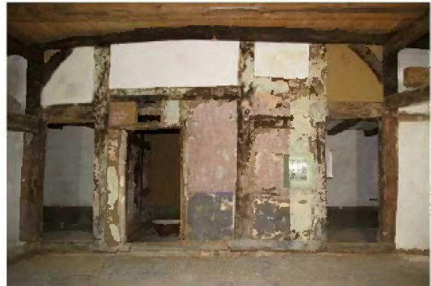
Abb. 1: Flettwand nach der Konservierung
