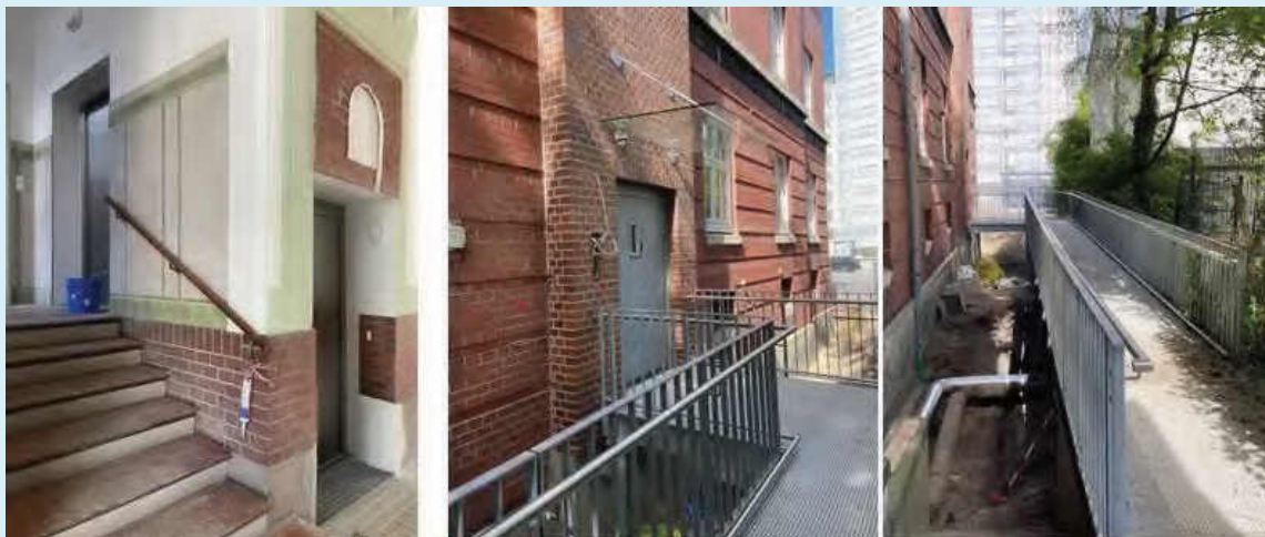
Abbildung 36: Aufzugssituationen großes Gartenhaus, Heerlein- und Zindler-Stiftung
