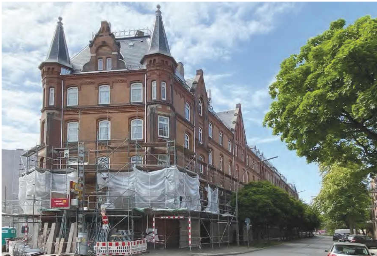
Abbildung 8: Stift III, Straßenansicht mit sanierten Dächern
