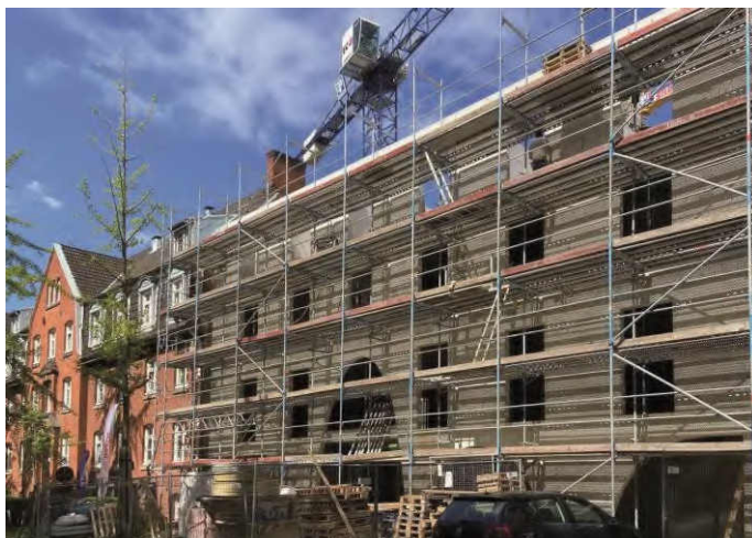
Abbildung 45: Neubau der Mara und Holger Cassens-Stiftung
