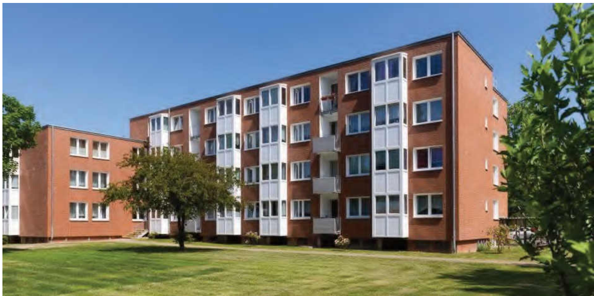
Abbildung 43: Wilhelm Carstens Gedächtnis-Stiftung, Gebäude nach der Sanierung
