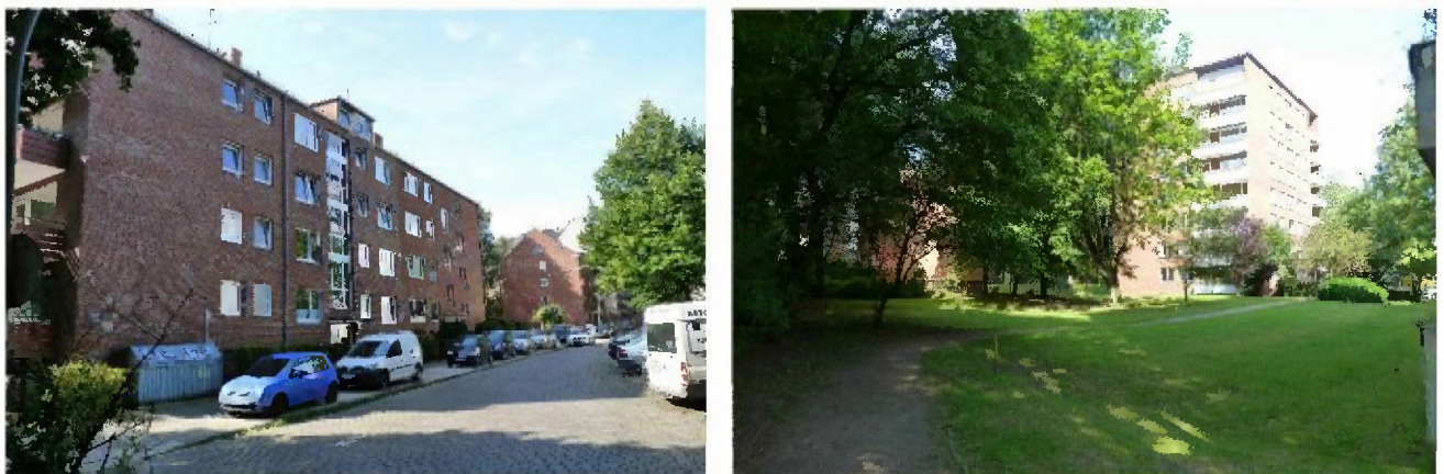
Abb. 4: links: Zeilenbebauung Paulinenallee, rechts: Hochhaus Fruchttaltee (Quelle: Foto konsalt GmbH)
