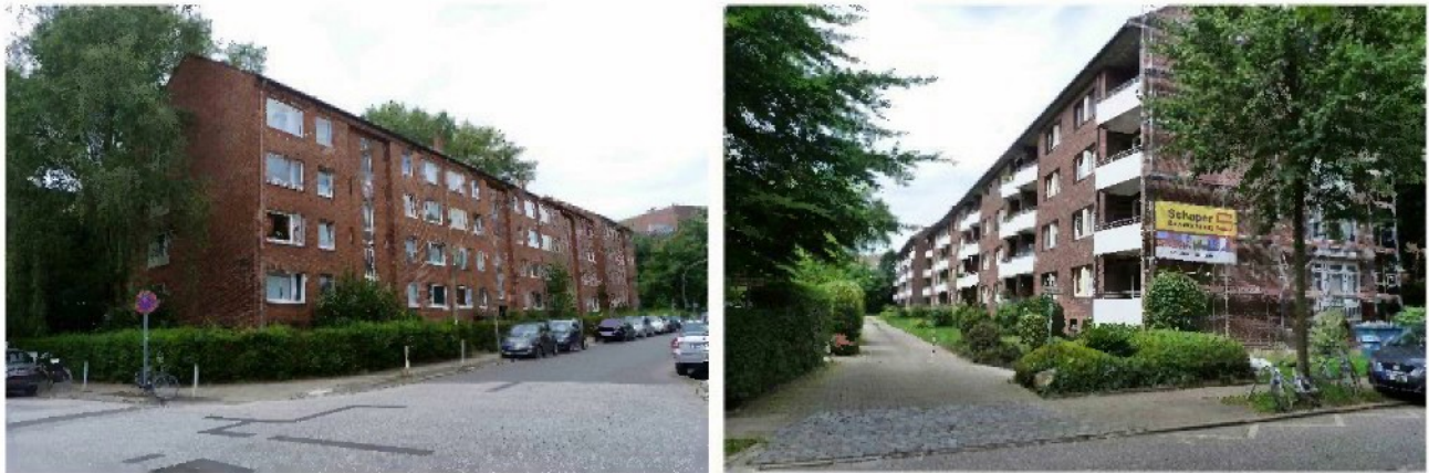
Abb. 5: links: Rotklinker am Wiesingerweg , rechts: Rotklinker in der Heckscherstraße (Quelle: Foto konsalt GmbH)
