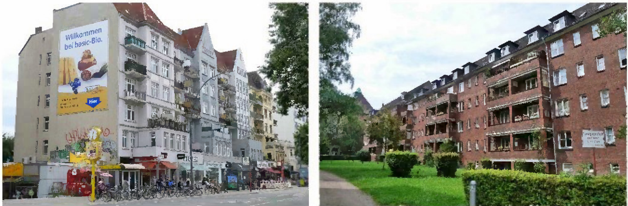
Abb. 6: links: Altbaubestand an der Osterstraße rechts: Rotklinerbauten Hohe Weide (Quelle: Foto konsalt GmbH)
