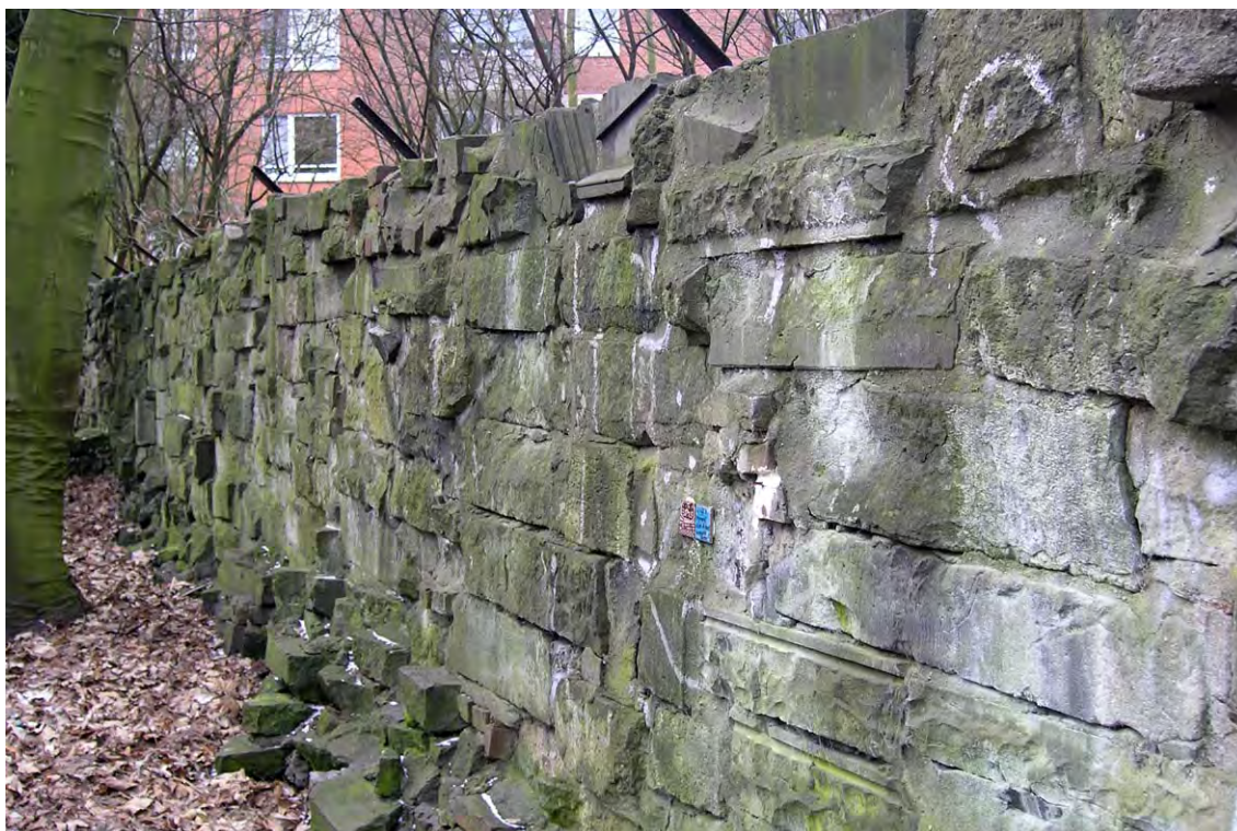
Foto 31 Einfassungsmauer Westeingang, Max-Brauer-Allee, aus alten Grabsteinen
