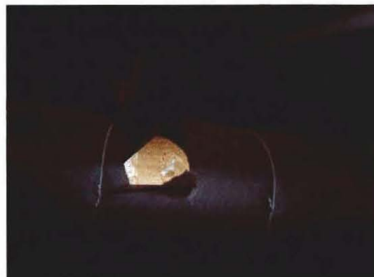
Abb. 8: Kriechkeller, KMF-Rohrisolierung mit Bitumenpapier
