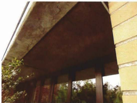
Abb. 7: Asbestzementplatten über dem Nebeneingang der Pausenhalle
