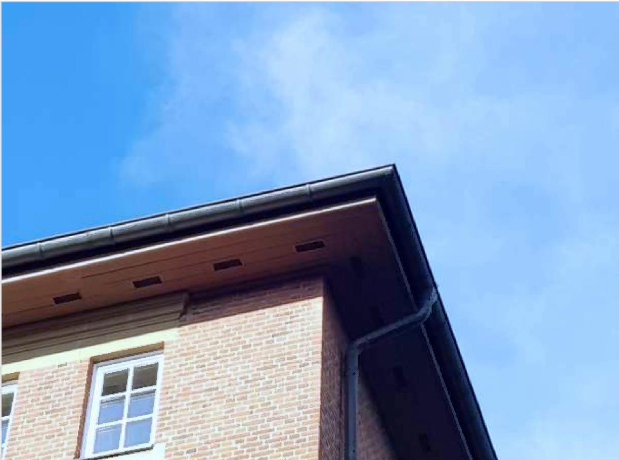
Abb. 12: Lüftungselemente in den Unterseiten der Traufkästen des Jenckelhauses
