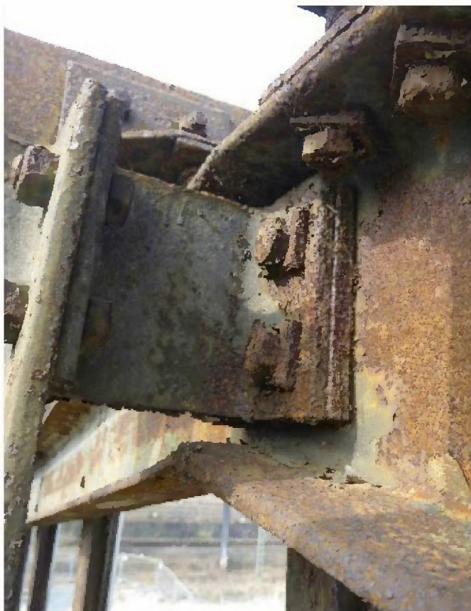
Achse AB/1 – Stahlprofil mit Korrosion
