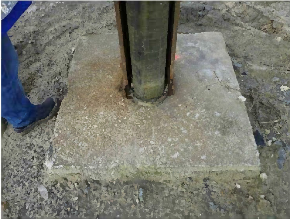
Achse C/1 – Fundament mit durchdringendem Rohr
