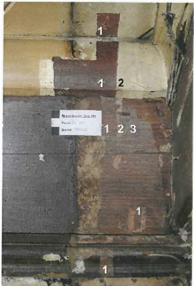
Foto Nr. EG 01-1.1DSCO3090.JPG
