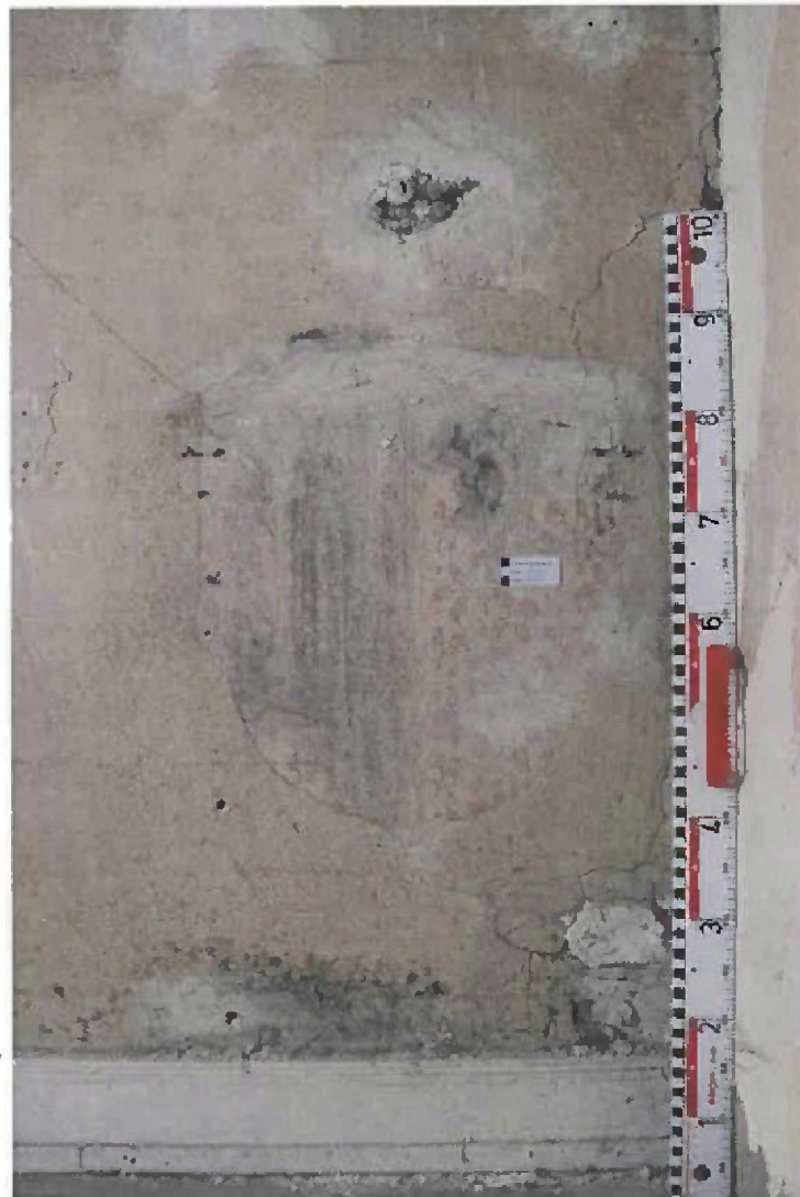
Foto Nr. OG 04 2.Übersicht DSC03435.JPG
