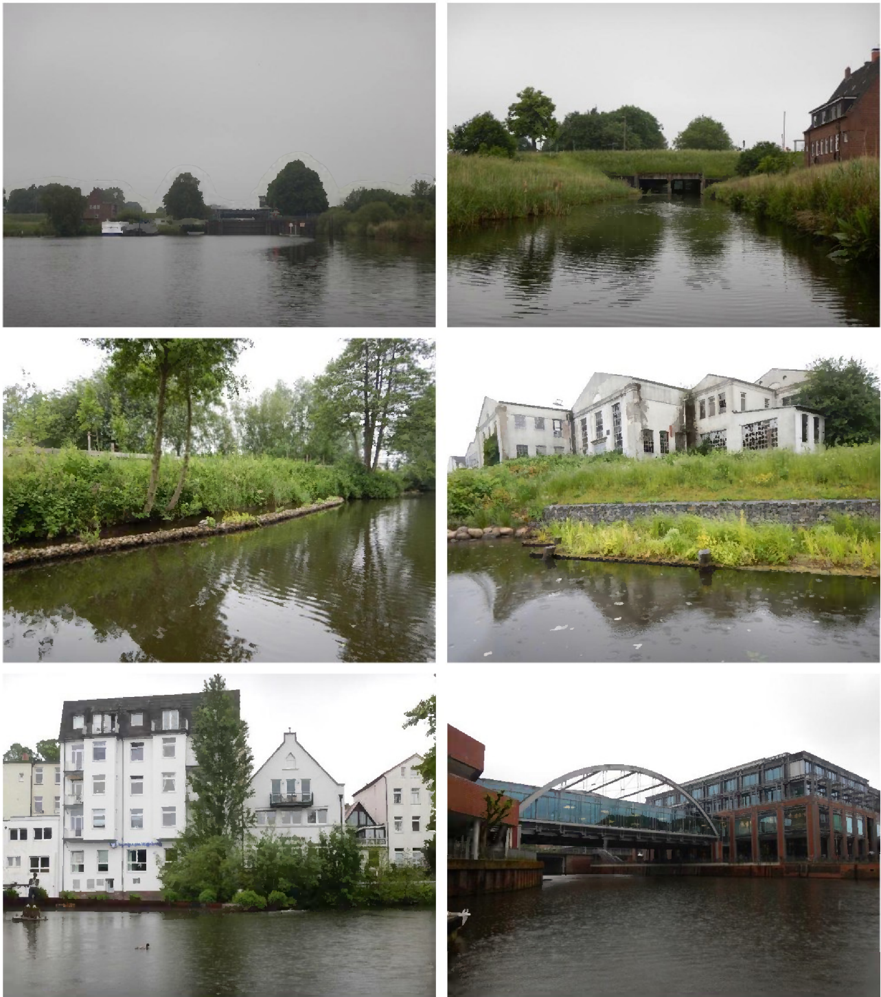
Abbildung 2: Eindrücke vom Schleusengraben/Serrahn (oben: Blick gewässerabwärts auf Krapphofschleuse (links) und Kurfürstenschosse mit Fischpass (rechts), Mitte: Gewässerstrukturmaßnahmen zwischen Kampbille und Sanderdamm, unten: Auslauf des Fischpasses in den Serrahn (links) und Blick vom Serrahn Richtung Schleusengrabenbrücke (rechts))
