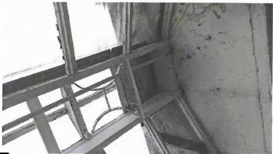
18 Anschluss Treibhaus 1 an Werkstattgebäude
