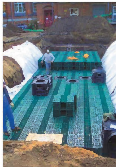
Abbildung 3 Einbaubeispiel; entnommen aus FRÄNKISCHE | RWM-Handbuch 8.0
