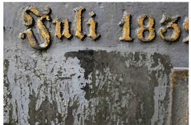
Unterschiedliche graue Beschichtungen, teilweise stark abblätternd GK1.
