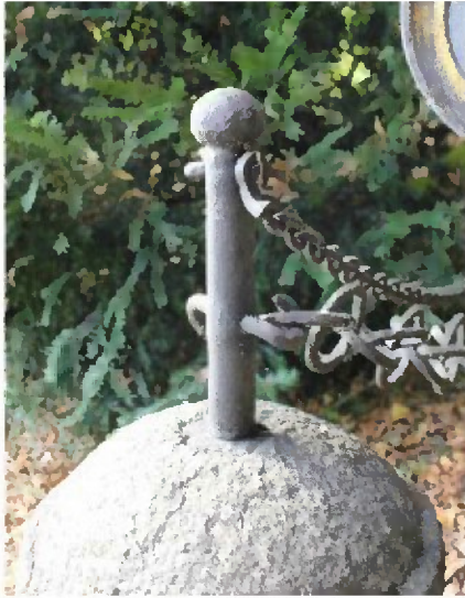
Abgebrochener Haken am Kettenhalter KH1. Beide vorderen Ketten fehlen (K4o/u).
