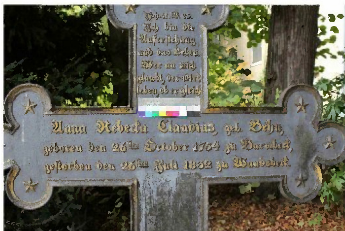
Abblättrende Deckschicht, Verschmutzungen und abgewitterte Vergoldung auf dem GK1.
