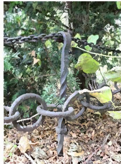
An dem Erdspeiß E1 fehlen die Haken zur Aufhängung der Ketten.
