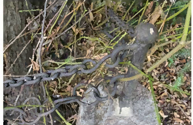
Zur Verlängerung der Kette (K2o) eingehakter S-Haken.
