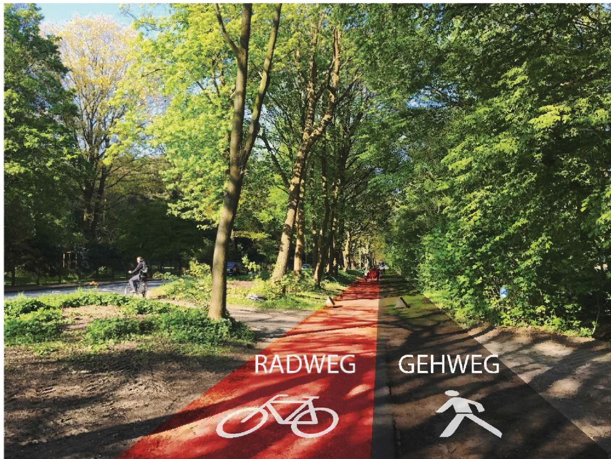
Abb. 41: Ausbau eines breiten, kombinierten Rad- und Gehweges auf der Südseite der Stadionstraße
