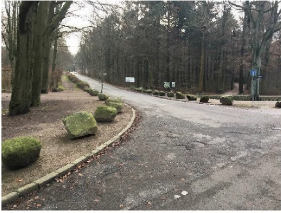
Abb. 44: Derzeitige Situation an der Ecke Nansenstraße / Max-Schmeling-Straße
