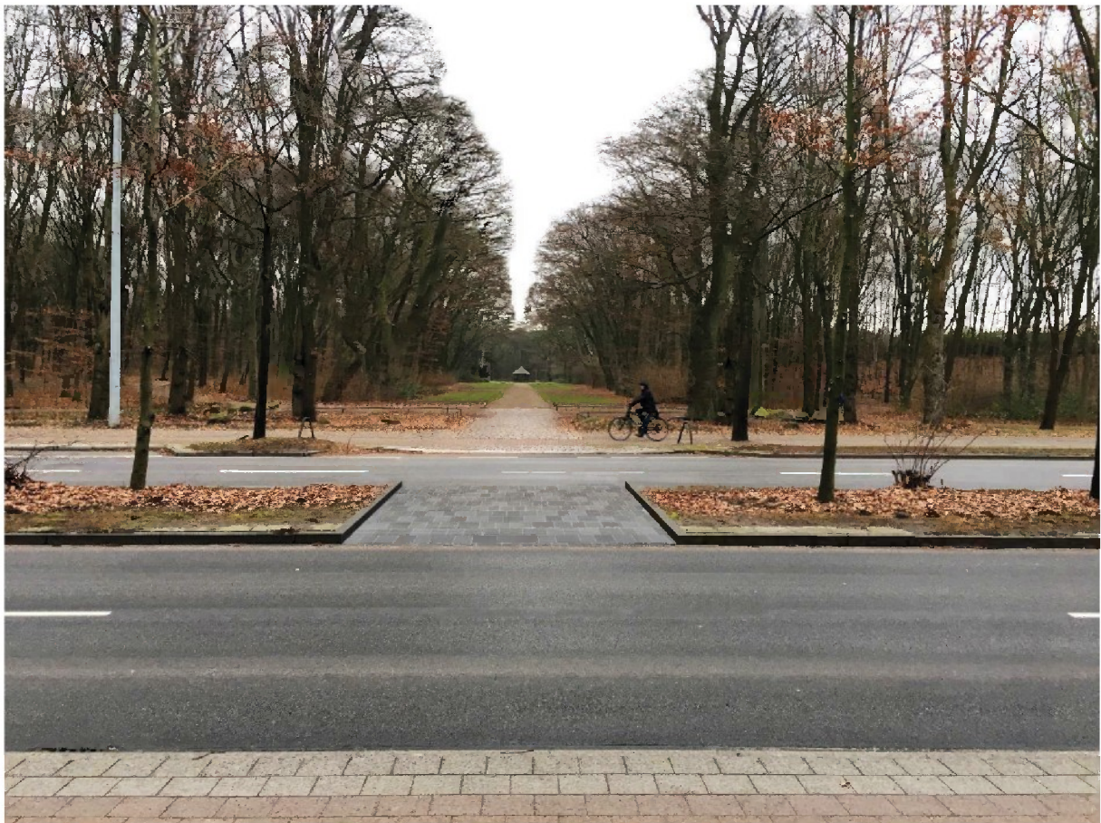
Abb. 24: Eingang Luruper Chaussee mit Einbau einer Sprunginsel zur leichteren Überquerung der Straße und Wiederherstellung der historischen Wegebeziehungen
