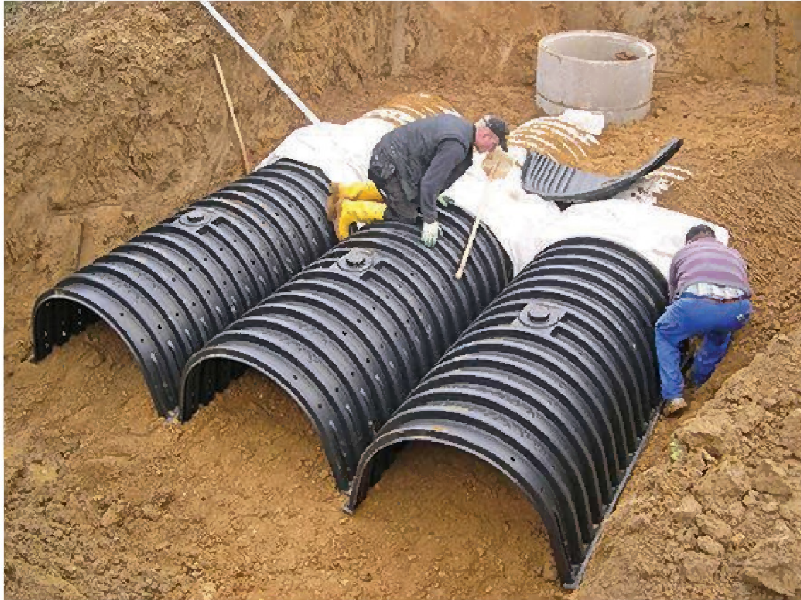
Drainmax Tunnel System mit drei Reihen Tunnel und ein Kontrollschacht im Zulauf.
