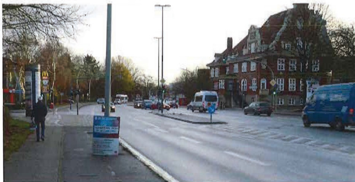
Abbildung 11: Knotenpunkt Sportplatzring/Basselweg/Koppelstraße, Blickrichtung Osten
