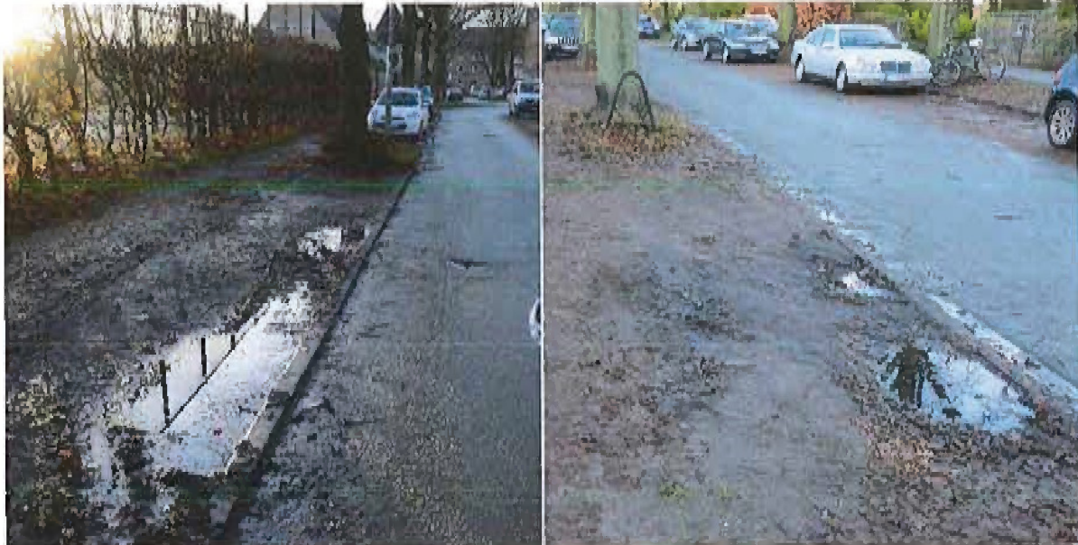
Abbildung 12: Durch ruhenden Verkehr verursachte Schäden in d. Nebenflächen (nördl./westl. Sportplatzring)
