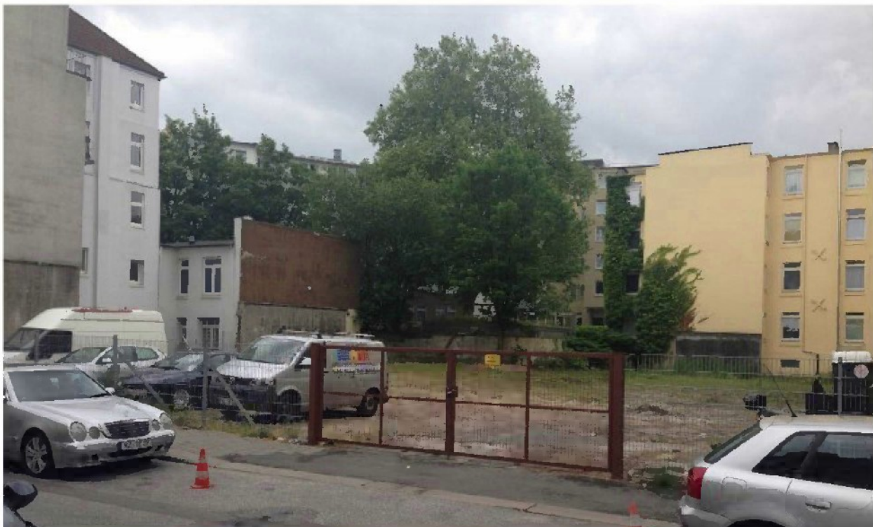
Abbildung: Die Gewerbegebäude Böckmannstraße 7-10 wurden 2014 für den geplanten Neubau von 21 Wohnungen abgebrochen
