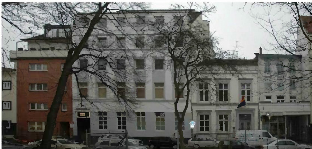
Abbildung: Erhaltenswerte Häuser am Pulverteich
