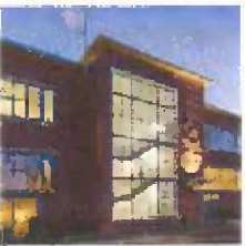
AJB Architekten Rindermarkthalle Neuer Kamp
