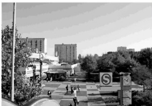
Abb. 21: Mantelbebauung vor Umgestaltung
