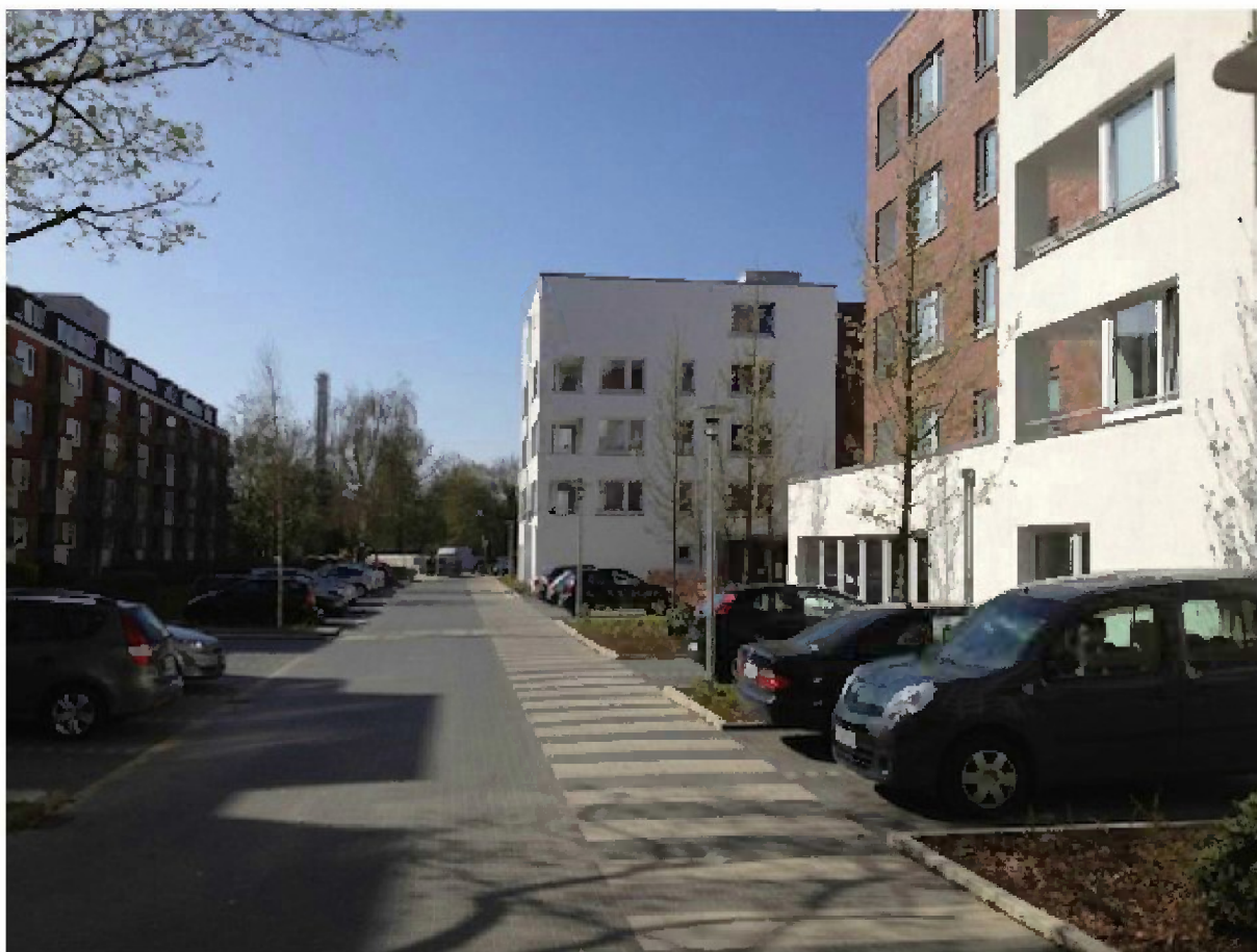
Abb. 40: Neue Stellplatzanlage Schwentnerring
