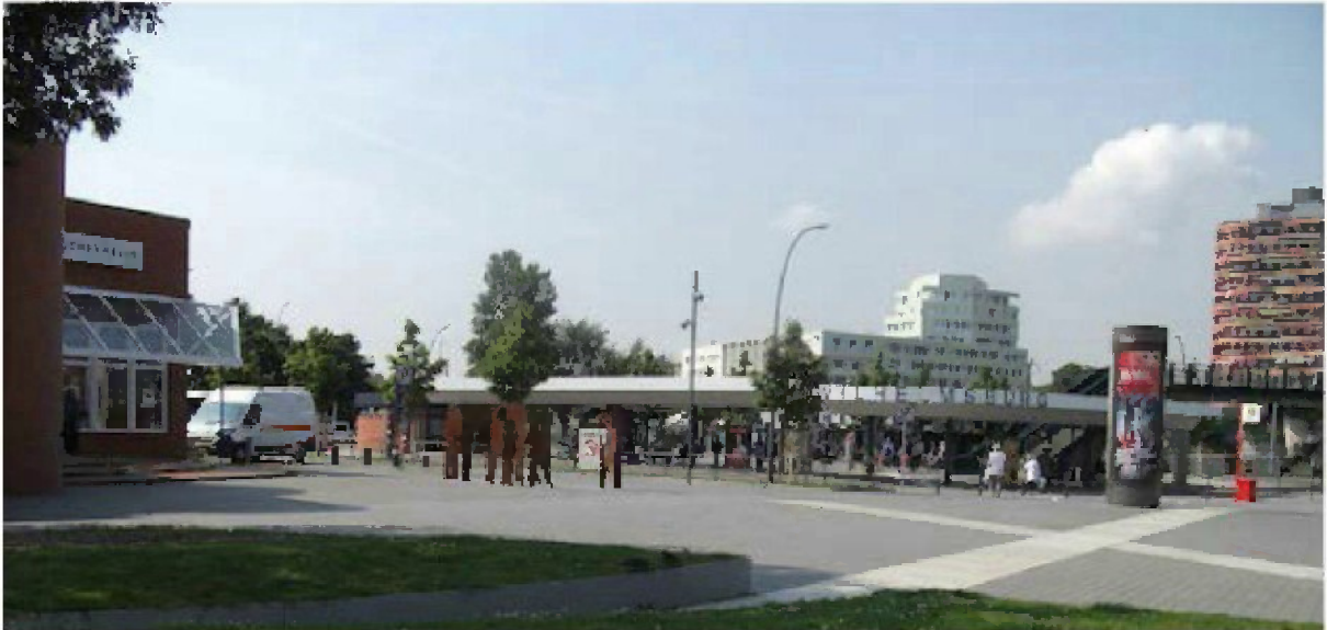
Abb. 37: Umgestalteter Busbahnhof und Bahnhofsvorplatz
