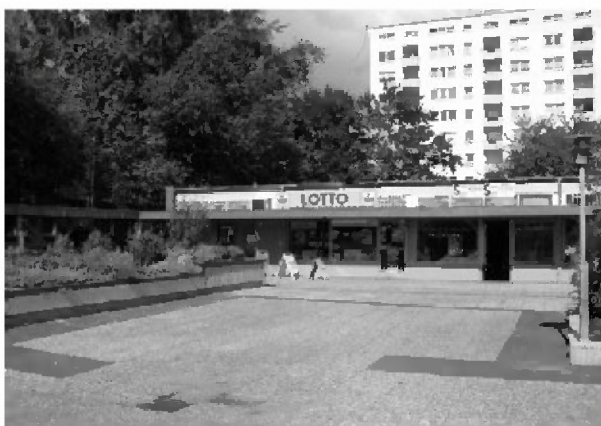
Abb. 29: Vor Neubau Seniorenwohnanlage
