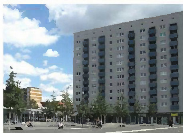
Abb. 26: Nach der Fassadensanierung
