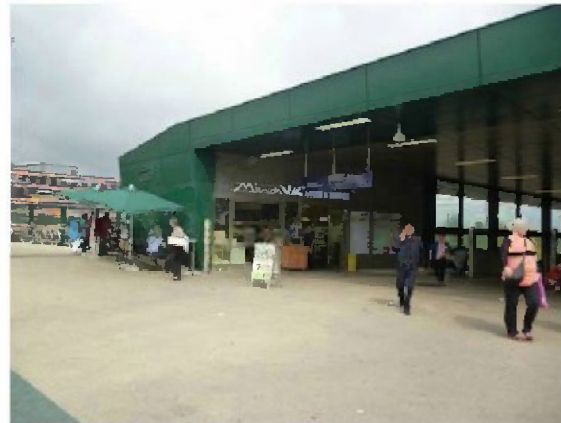
Abb. 39: Zugang S-Bahnhof nach Umbau
