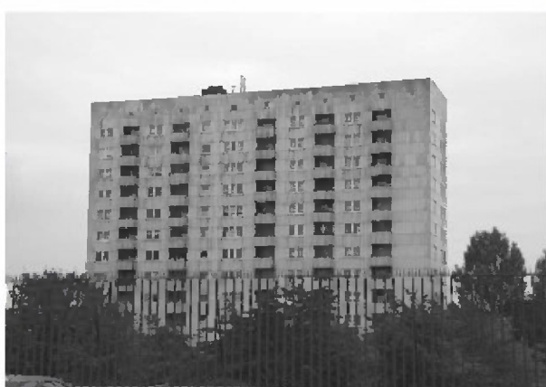
Abb. 25: Vor der Fassadensanierung
