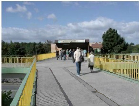
Abb. 38: Zugang S-Bahnhof vor Umbau
