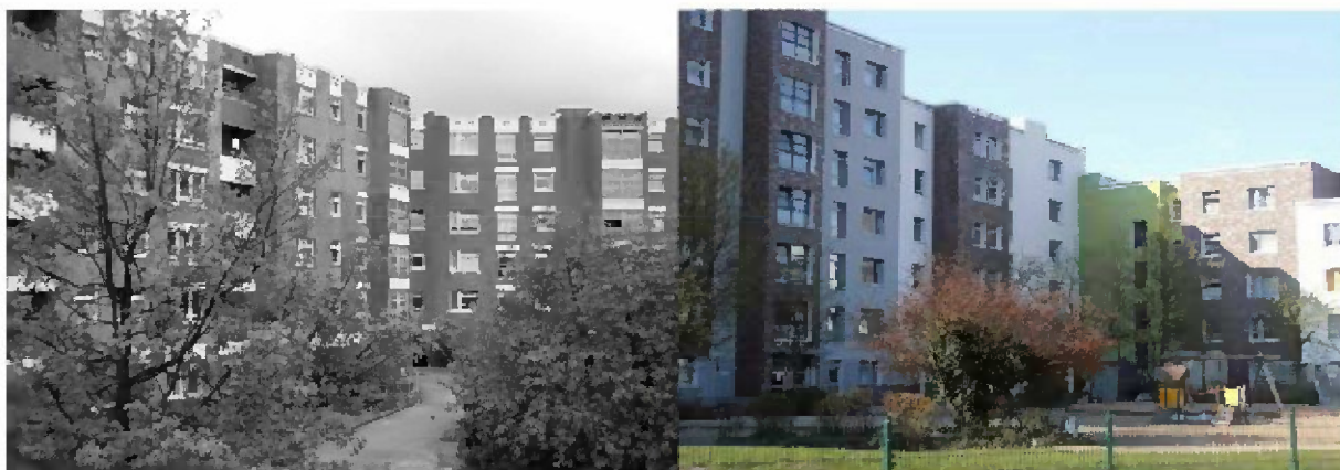
Abb. 27: Vor Fassadensanierung Krieterstr. 32 - 54
