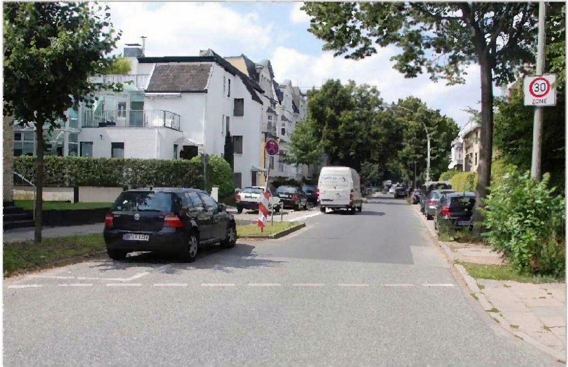
Bild 4.2.1 - 4 Fahrbahneinengung in der Klärchenstraße
