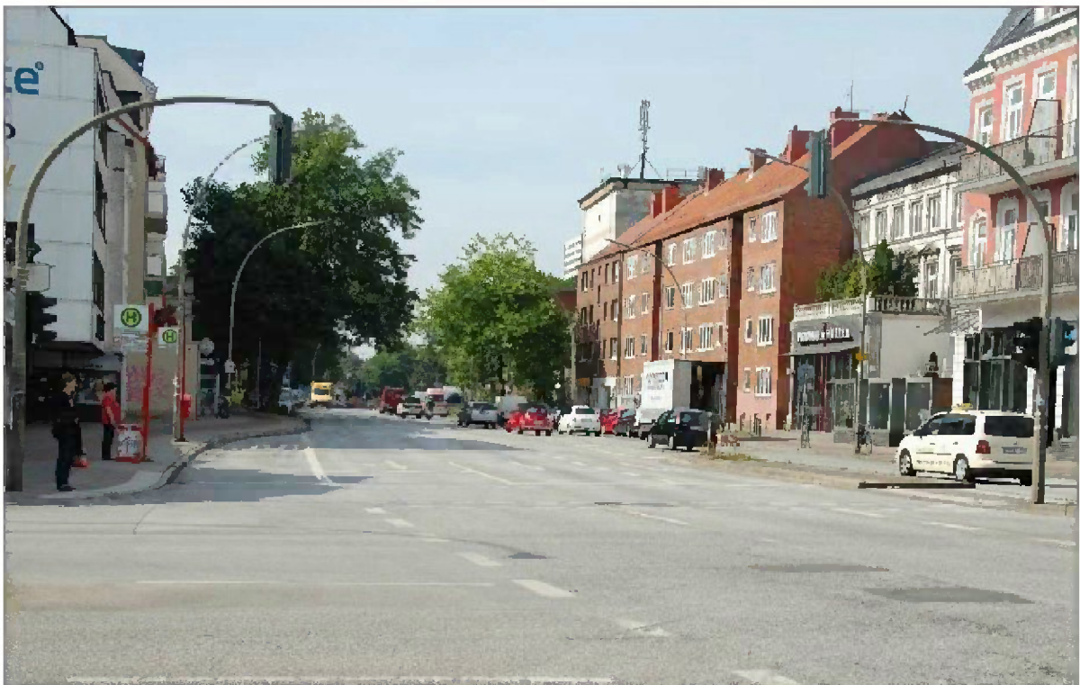
Bild 2.2.15 - 2 Haltestelle Schulweg in FR→S-Rübenkamp/ Sachsenstraße, Blickrichtung Süd
