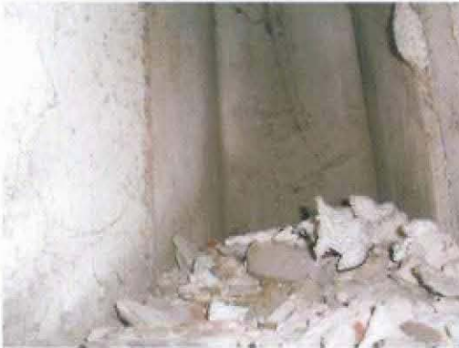
Abb. 9: Asbestzementformteil als Abluft im Heizungskeller
