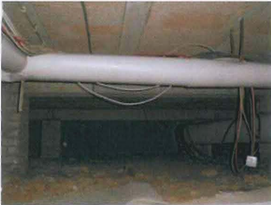
Abb. 21: KMF-Dämmung um diverse Rohrleitungen z.B. im Kriechkeller
