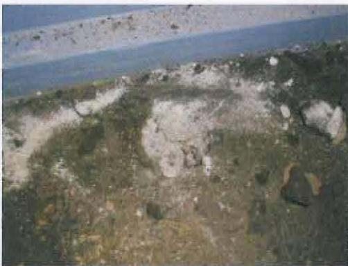
Abb. 6: Gussasphalt auf einer Trennlage
