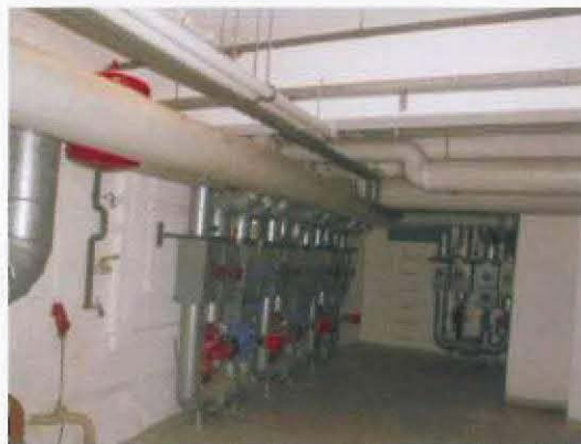
Abb. 14: Armaturen mit asbesthaltigen Flachdichtung
