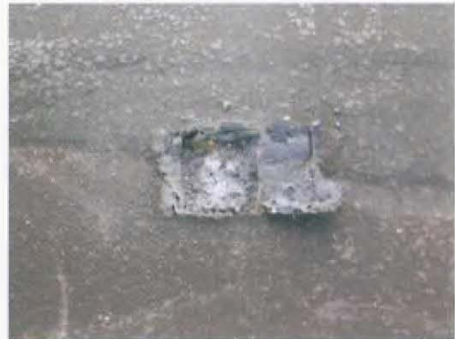
Abb. 5: Schwarzabdichtung auf dem Dach
