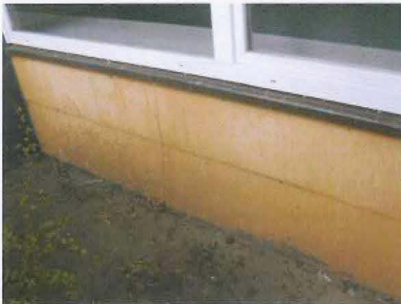
Abb. 15: Asbestzementplatten auf einer UK im Brüstungsbereich
