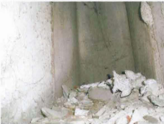
Abb. 16: Asbestzementformteil als Abluftzug
