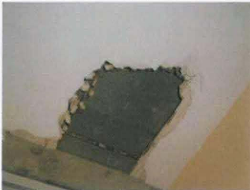
Abb. 4: Bimsbetondecken mit Rabitzdecke abgehängt
