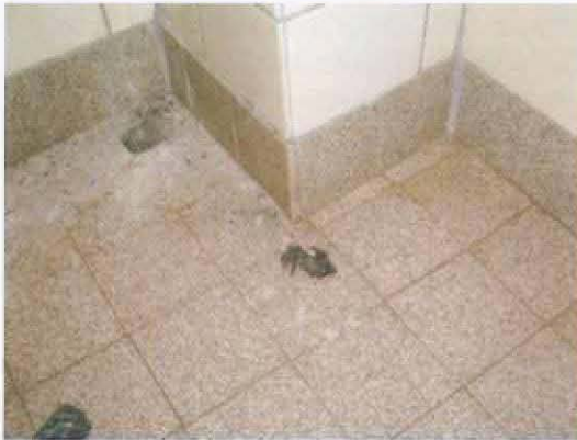
Abb. 17: Probe A12.074-22 schwarze Abdichtung unterhalb des Estrichs
