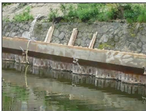
Ei 2: Nach Sanierung - Metallspundwand
