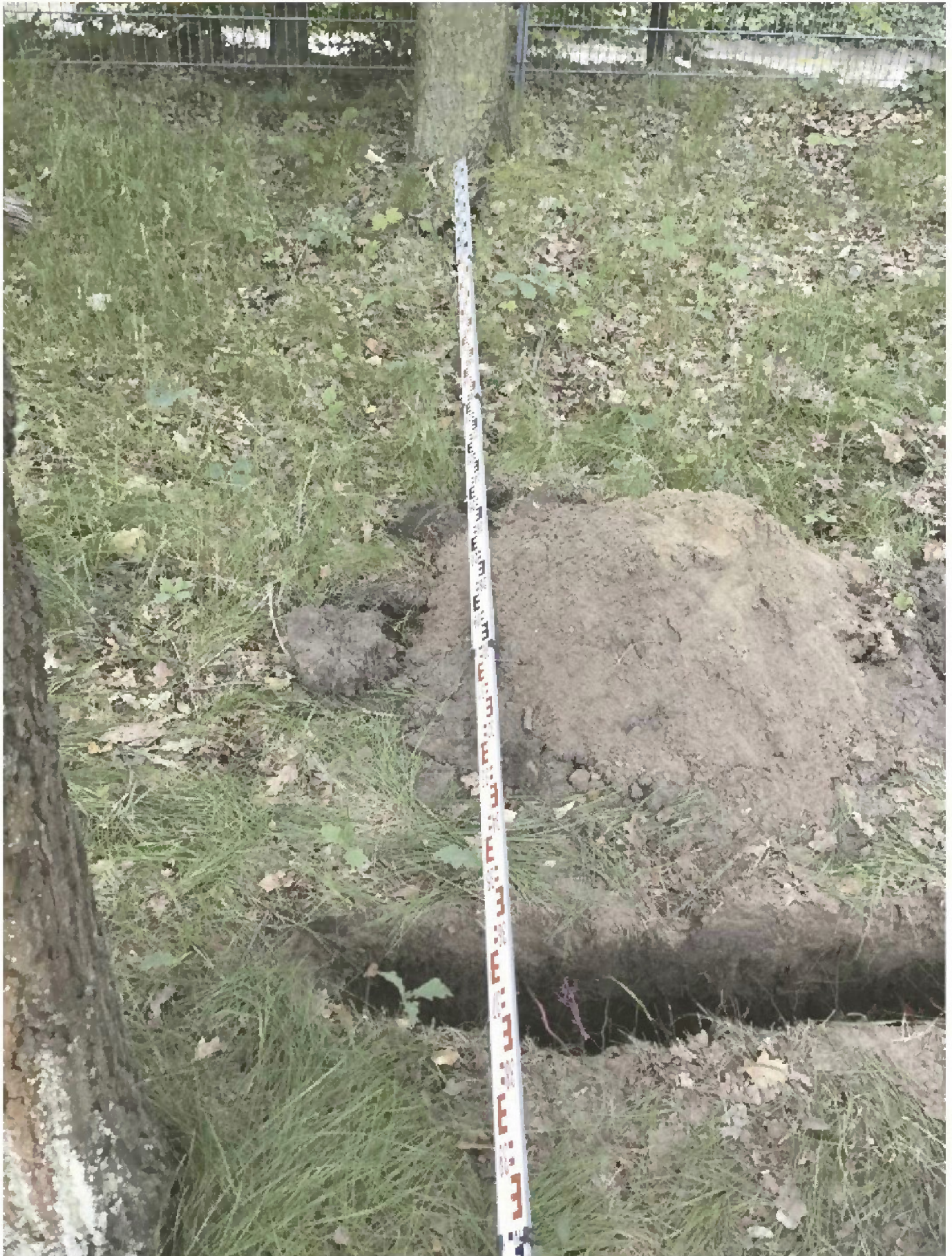
Abb.17: Suchgraben (d) - Baum Nr. 149 und Nr.151, im Abstand von 3,5m zu Baum Nr. 149
