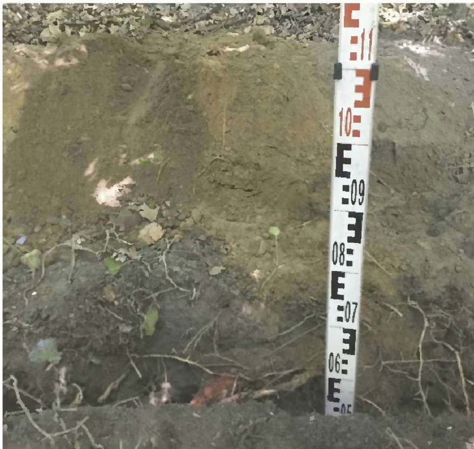
Abb.12: Suchgraben (b) - Baum Nr. 96, Tiefe zw. 0,7m und 0,8m
