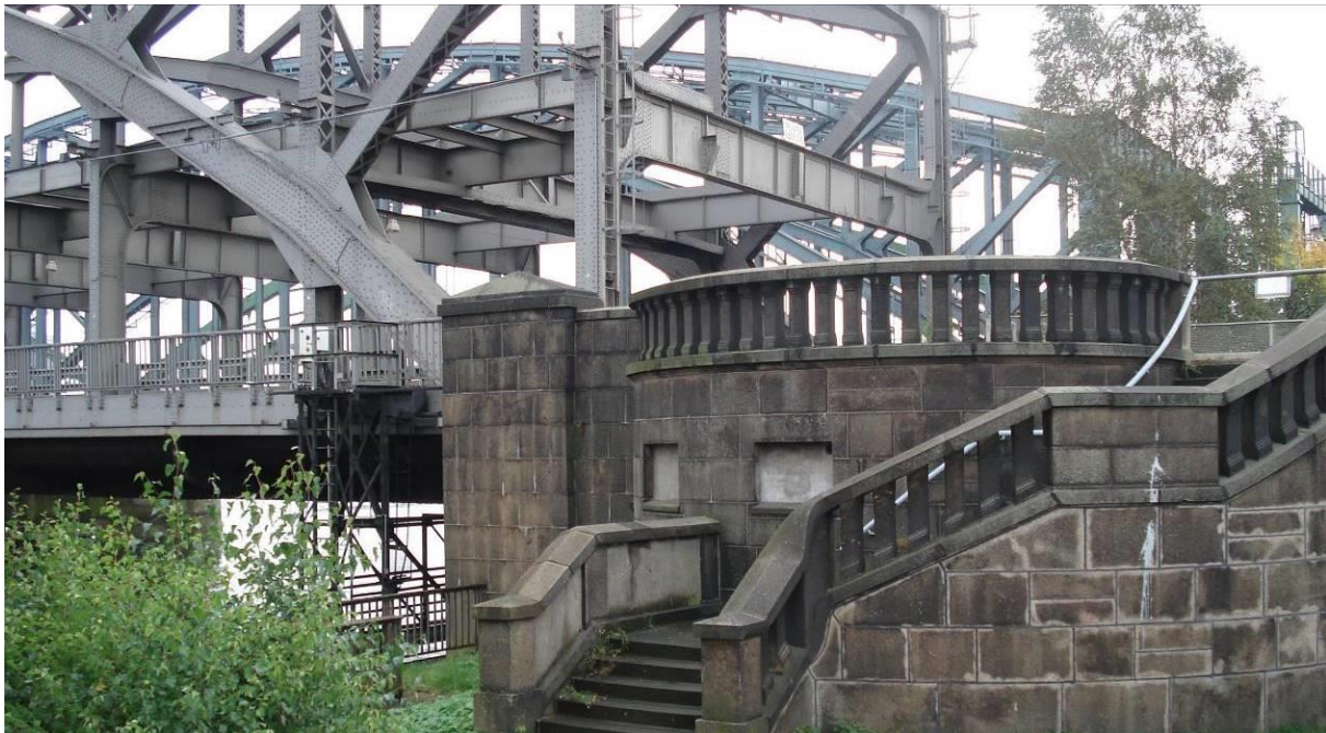
Abb. 138: Freihafenelbbrücke, Blickrichtung Nordost (Quelle: Elbberg Stadtplanung)
