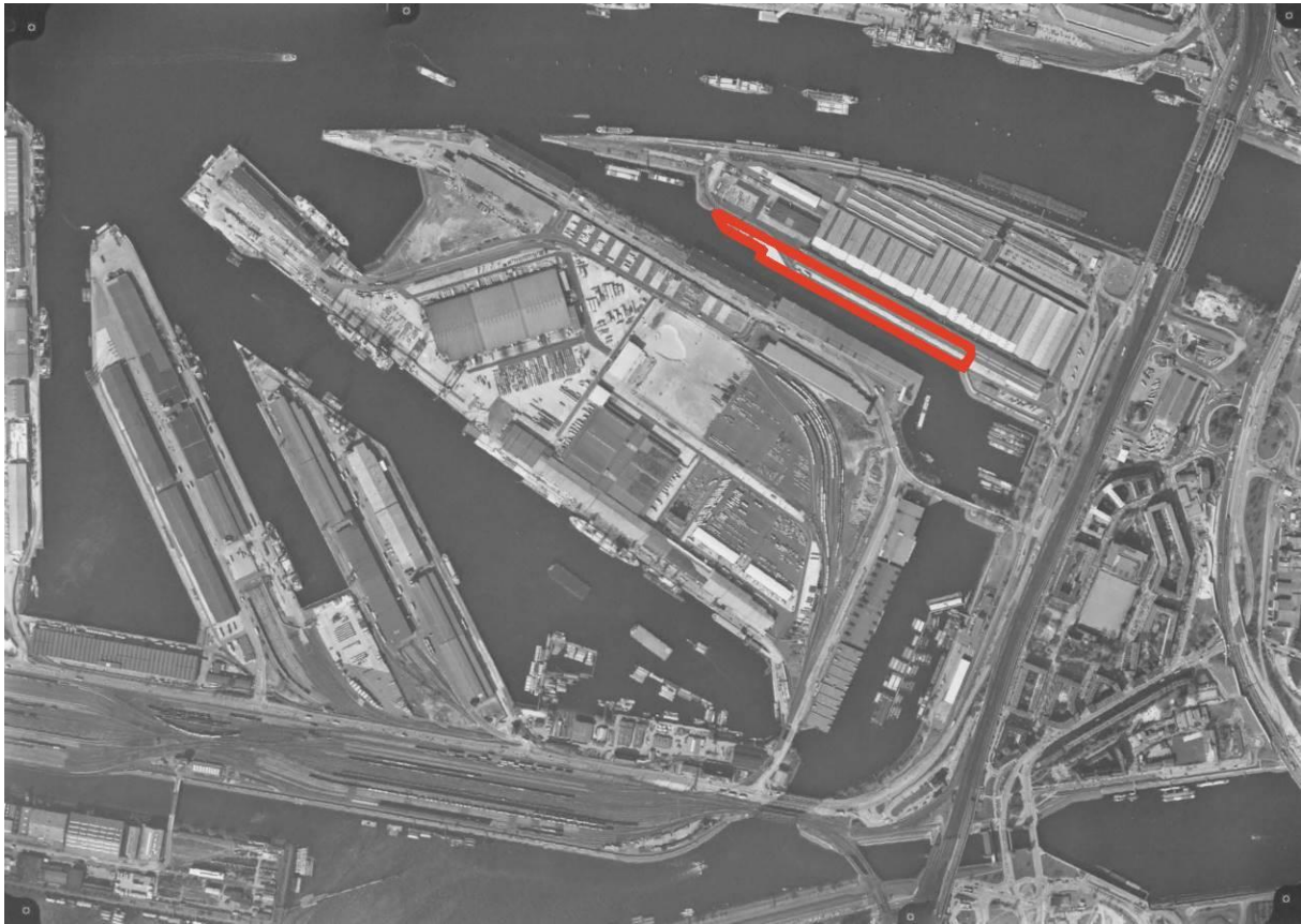
Abb. 23: Bereich des Untersuchungsgebietes 1990, zusammengesetzt, Ausschnitt. Rot umrandet sind die Landflächen, die zwischen 1980 und 1990 im Untersuchungsgebiet aufgeschüttet wurden (Quelle: Staatsarchiv Hamburg, 50-90 Str.15-4110 (02.04.1990), 50-90 Str.15-4112 (02.04.1990); zusätzlich eigene Darstellung).
