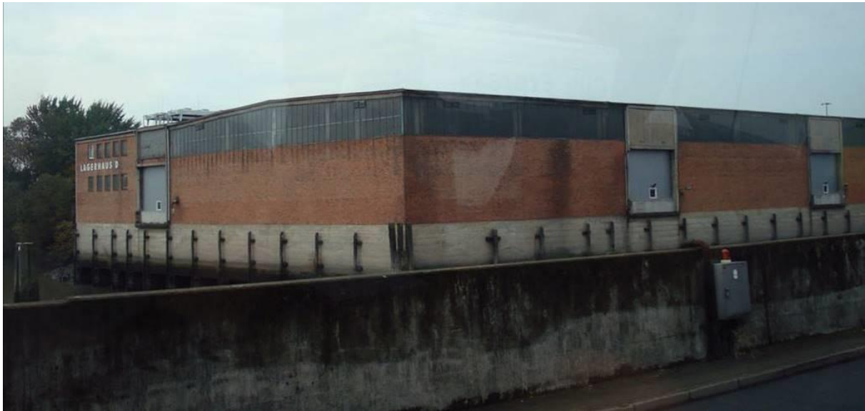
Abb. 137: Lagerhaus D am Moldauhafen, Blickrichtung West (Quelle: Elbberg Stadtplanung)
