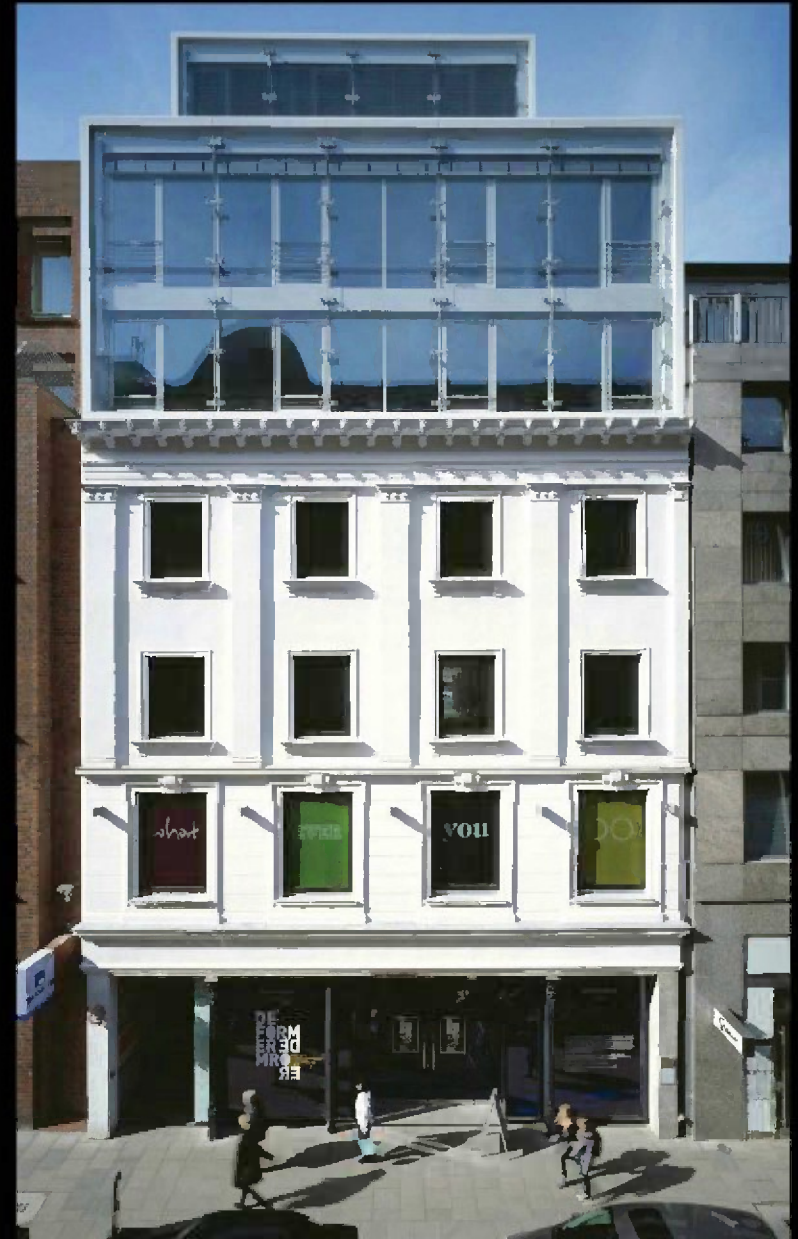
Große Bleichen 34 | neue Nutzungen in historischen Gebäuden
