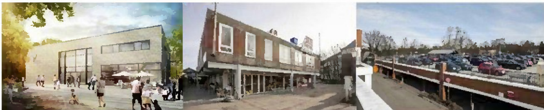
Abbildung 13: Stadtteilhaus, Gebäude Rennbahnstraße 29, P+R-Parkpalette
