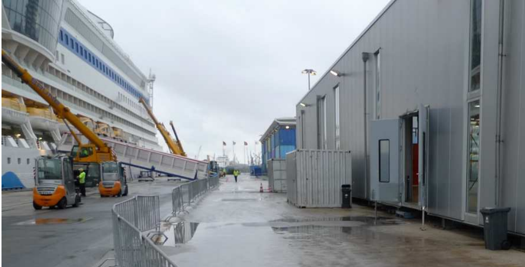
Abbildung 25: Be- und Entladung mit 3 Autokränen am 19.6.2015
