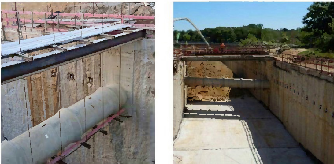
Abbildung 19: Beispiel Leitungsquerung DN 1200, Sicherung mittels Brückenkonstruktion (Stand: 04.2019)
