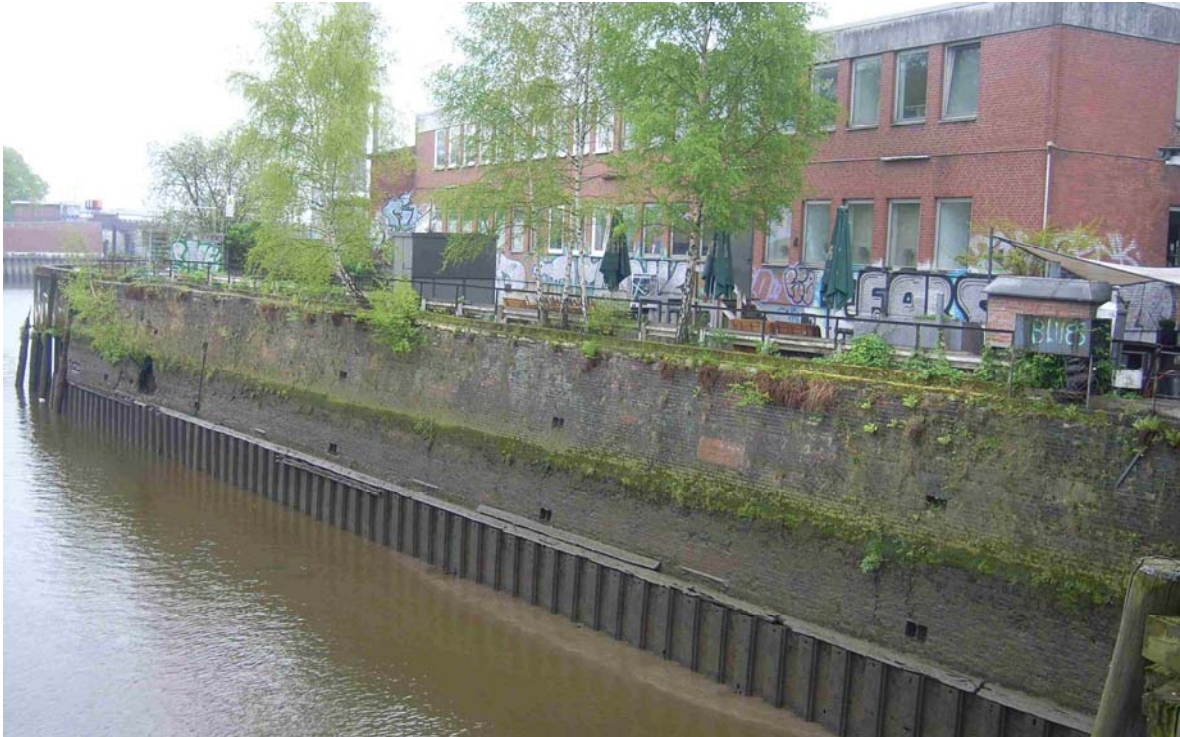
Abbildung 1: Kaimauer aus Ziegeln im Bereich der Oberhafenkantine
