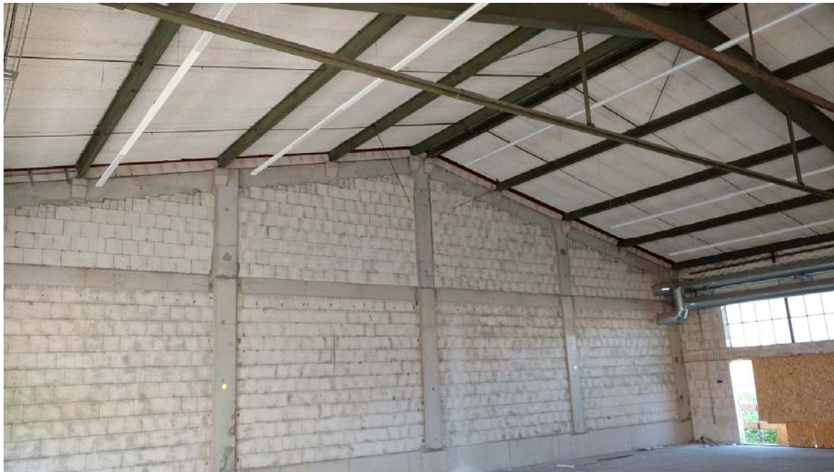
Abbildung 3: Hallenausschnitt mit Betonplatten und Stahlkonstruktion im offenen Dachbereich
