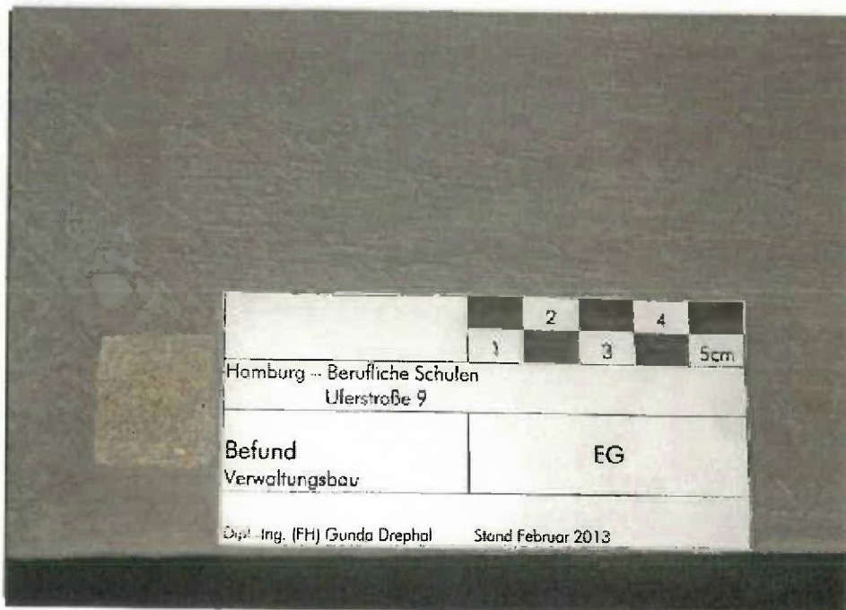
Befund Nr. 4 ● Treppenunterseite
