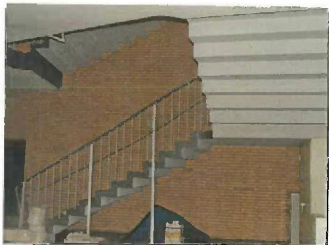
Haupttreppenanlage zu den Obergeschossen. Die Eisenstäbe, die zur Stabilisierung des Treppengeländers auf dem Fußboden montiert sind, sind nicht bauzeitlich.
