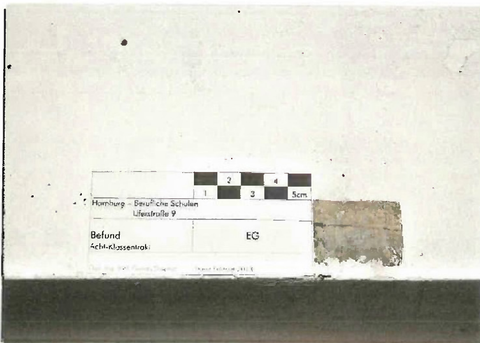
Befund Nr. 6 ● Treppenunterseite
