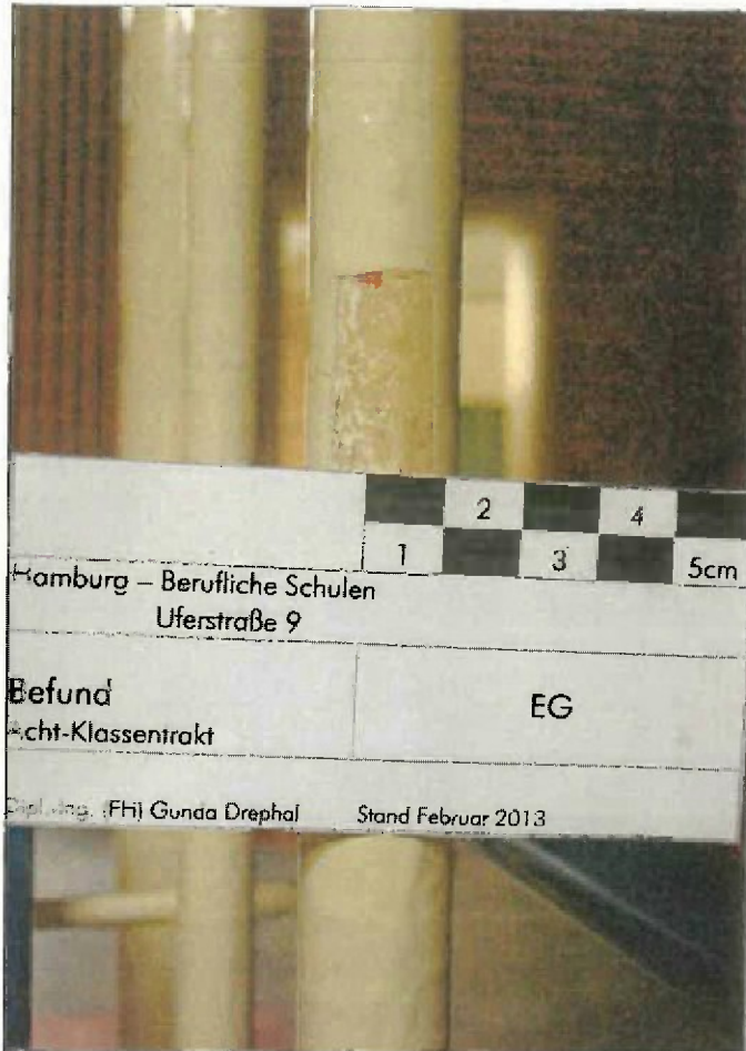
Befund Nr. 7 ● Geländerstangen Eingangsbereich
