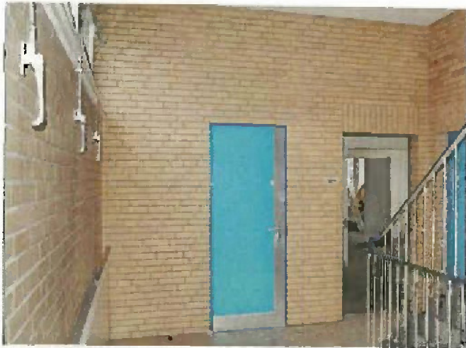
Erdgeschoss Zugang zum Haupttreppenhaus.
