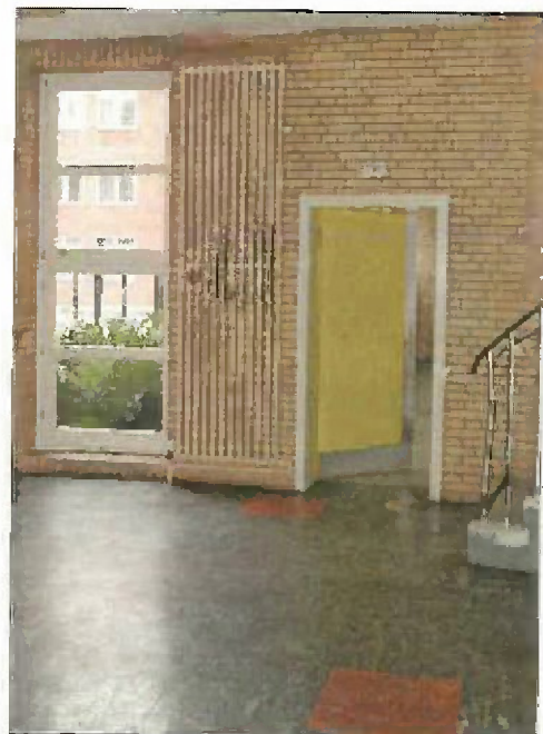
Treppenhaus 1 Die Innentüren zu den Unterrichtsräumen sind in einer Holzcharge eingefasst. Auch hier ist der bauzeitliche Fußbodenbelag noch vorhanden.
