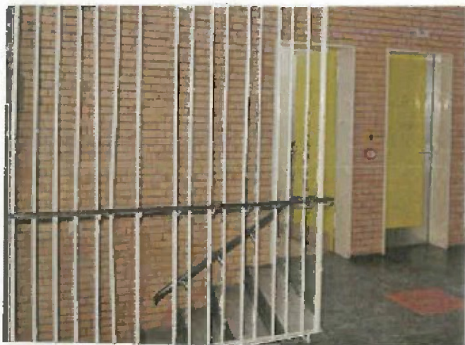
Treppenhaus 1 Eingangsbereich mit raumhohen Geländerstäben Die Türen zu den Sanitärbereichen sind in einer Metallzarge eingefasst.
