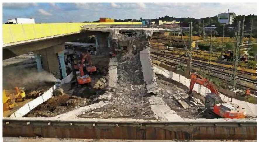
Abriss östl. Fahrbahn Brücke Langenfelde
