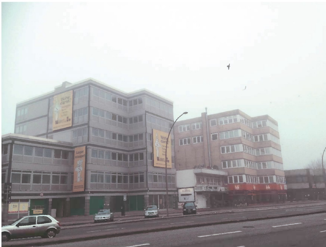
Gewerbebauten an der Hamburger Straße, Blick Richtung Nordwesten.
