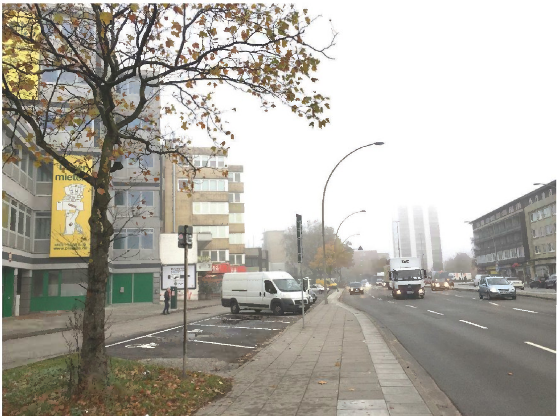
Gewerbebauten an der Hamburger Straße, Blick Richtung Norden.
