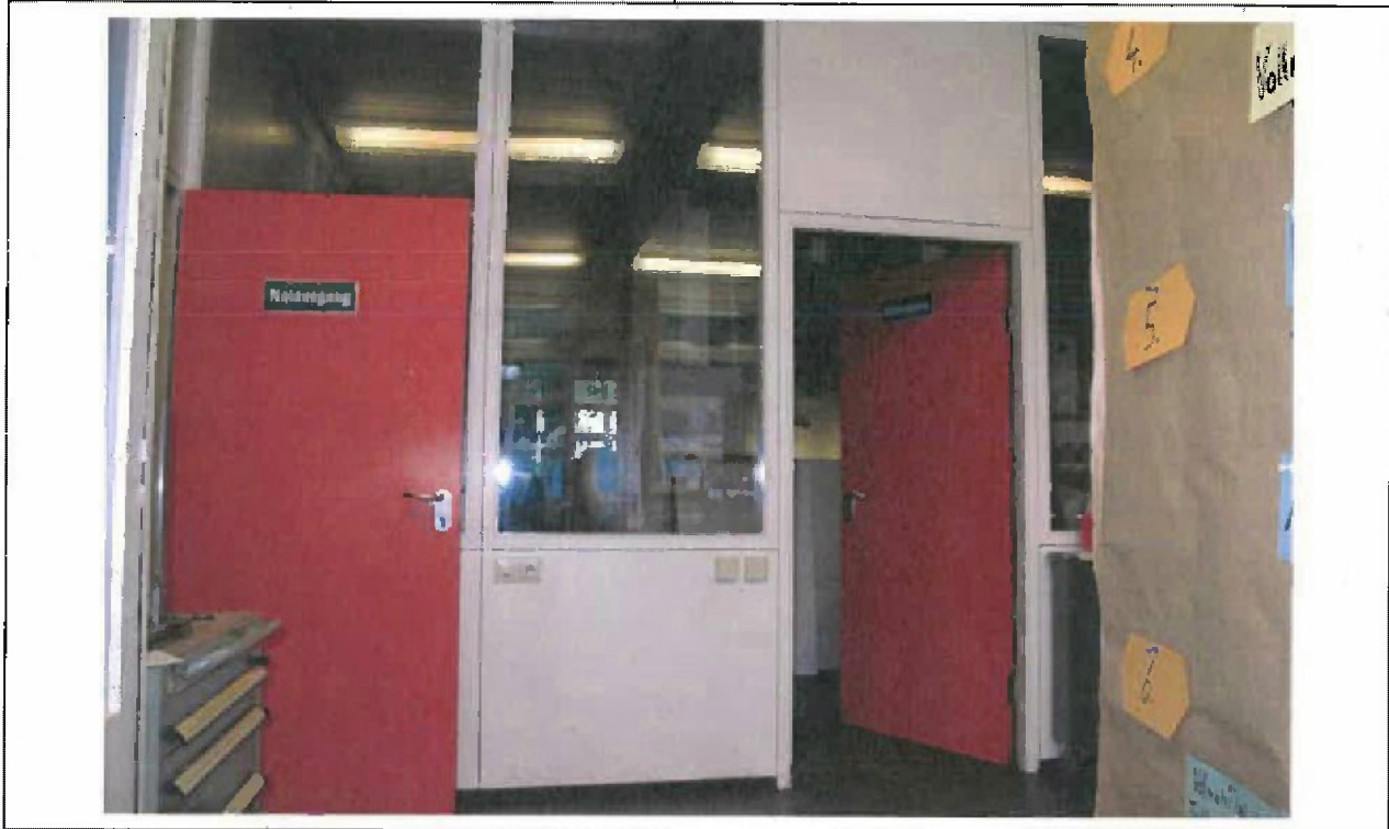
Bei diesen Kunststofftüren handelt es sich wahrscheinlich um Sicherheitstüren mit Signalwirkung. Sie sind bauzeitlich und der Farbton ist ähnlich den orangefarbenen Beton-Anstrichen.
