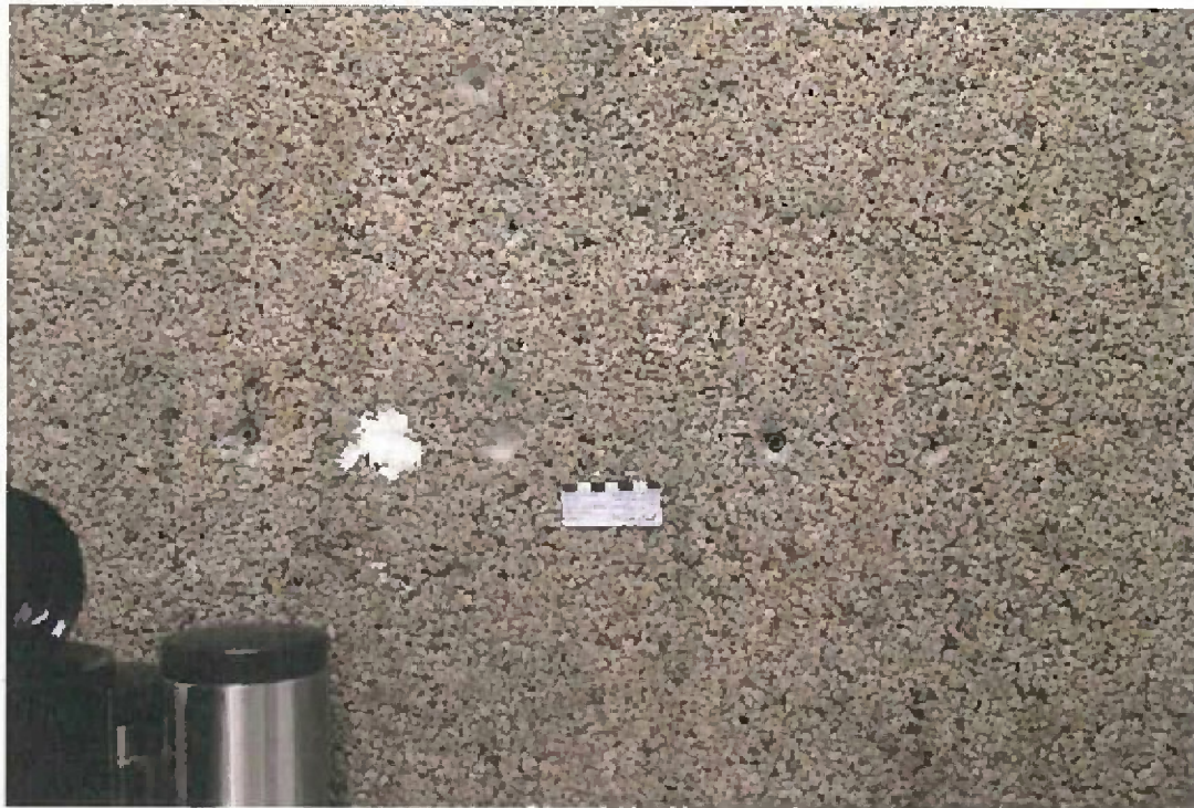
Hier sind einige Schäden an einer mit Caluplast beschichteten Wand. Es handelt sich meist um Bohrlöcher.
