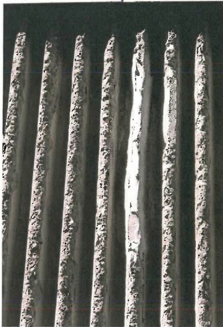
Unsachgemäße Betonergänzung auf einem Steg. Dadurch wurde der Charakter der Oberfläche stark verändert.
