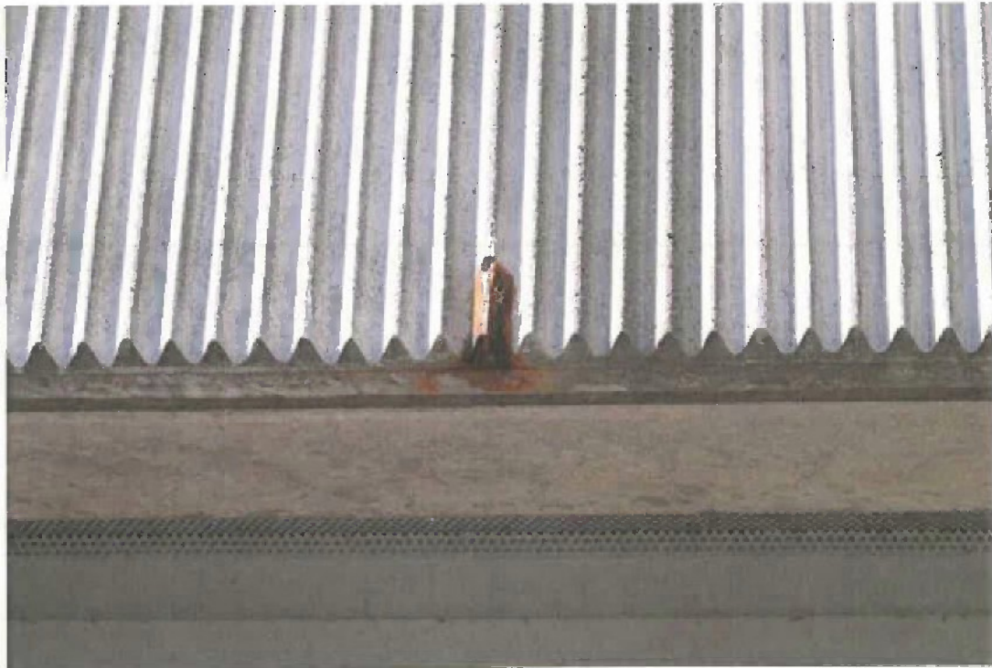
Massive Rostablagerungen am unteren Rand.
