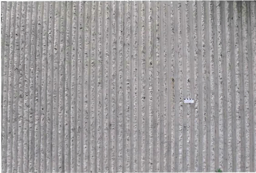
Auch hier ist ein Läufer von Rost sichtbar.
