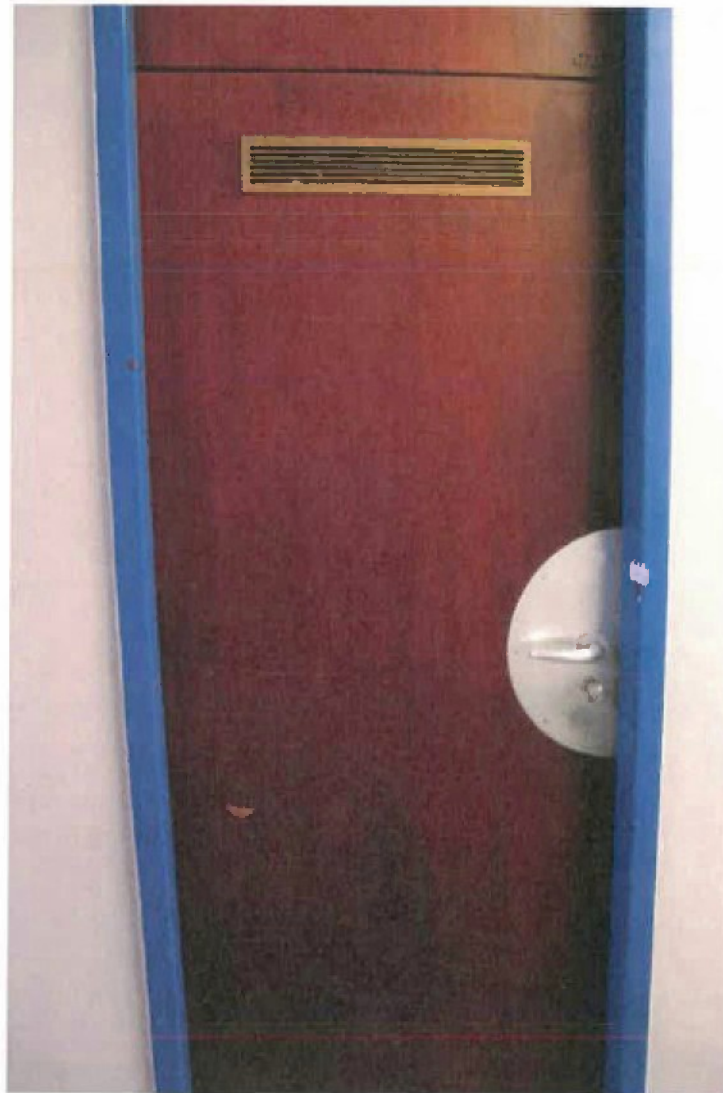
Bei den Türen handelt sich um furnierte Holztüren, die mit einem Klarlack überzogen sind. Der Lack löst sich in Äthanol an.
