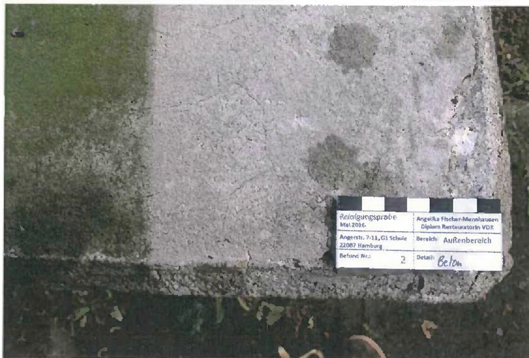
Reinigungsprobe mit Wasser mit einem Zusatz von Tensid brachte ein sehr gutes Ergebnis.
