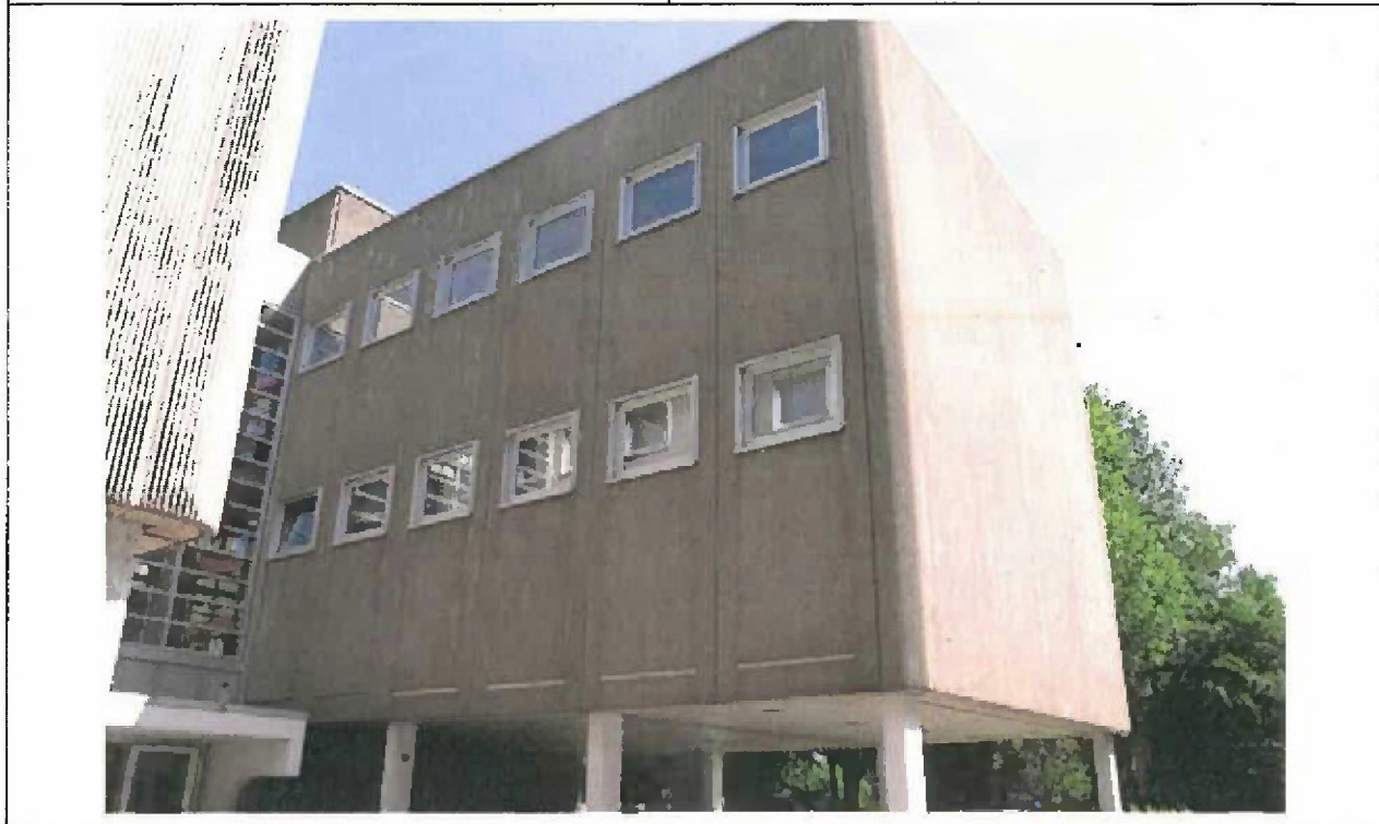
Gesamtansicht der Fassade im Eingangsbereich.
