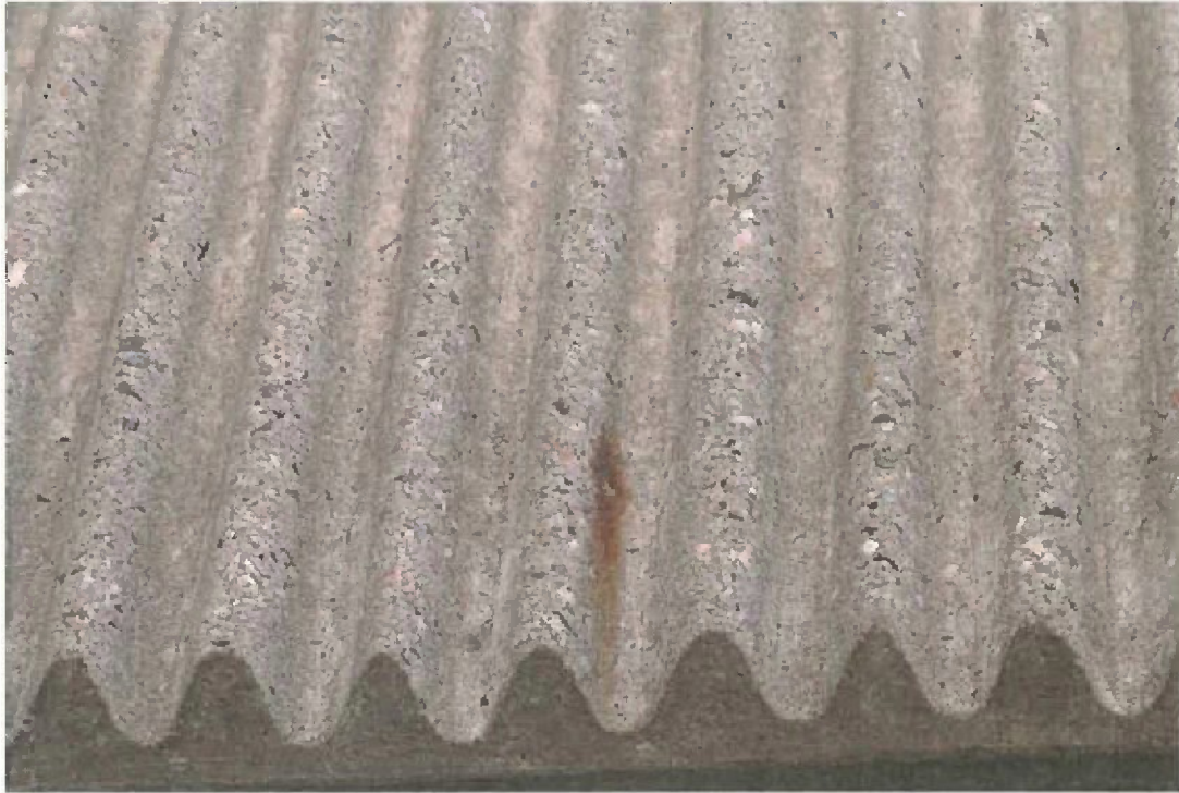
Läufer von Rost, verursacht von Einlagerung von Eisen. In den Tiefen ist die Lasur noch erhalten, auf den Höhen der Stege ist sie abgewaschen und die Zuschlagstoffe treten zutage.
