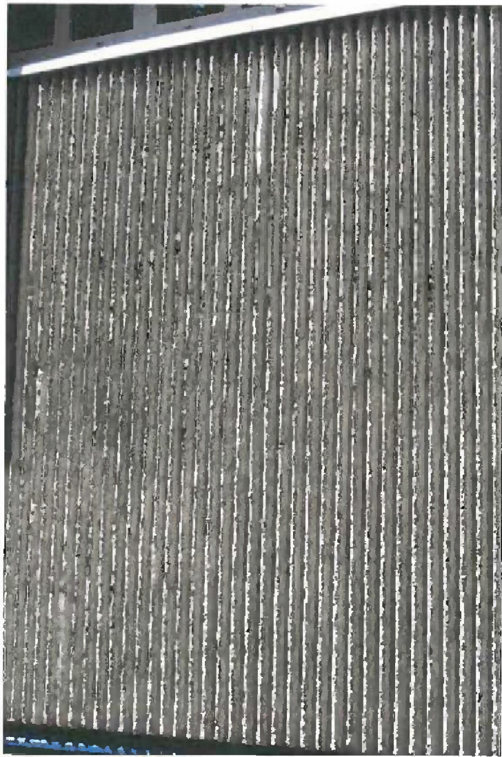
Am oberen Bereich unsachgemäße Betonerfüllungen, der Schaden des abgerochenen Steges befindet sich am linken Bildrand.
