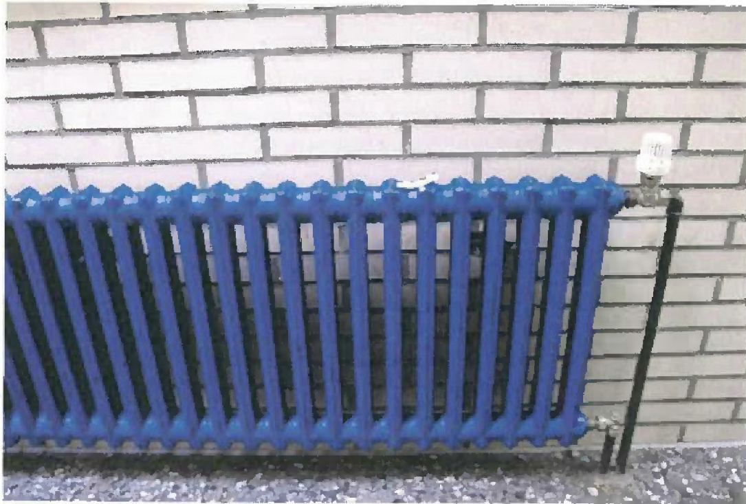
Hier ist noch der bauzeitliche Anstrich sichtbar.
