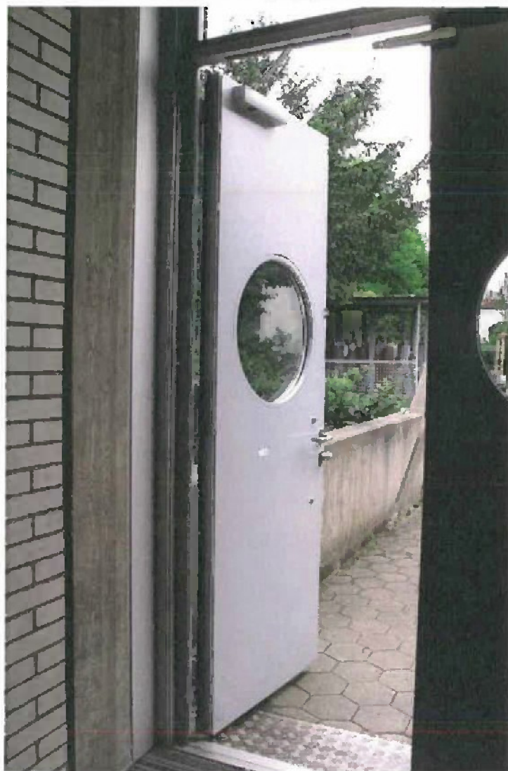
Diese Tür ist nicht bauzeitlich
