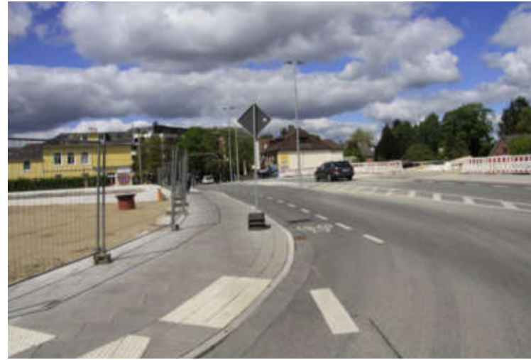
Abb. 27: Autobahndeckel im Bereich der Frohmestraße
