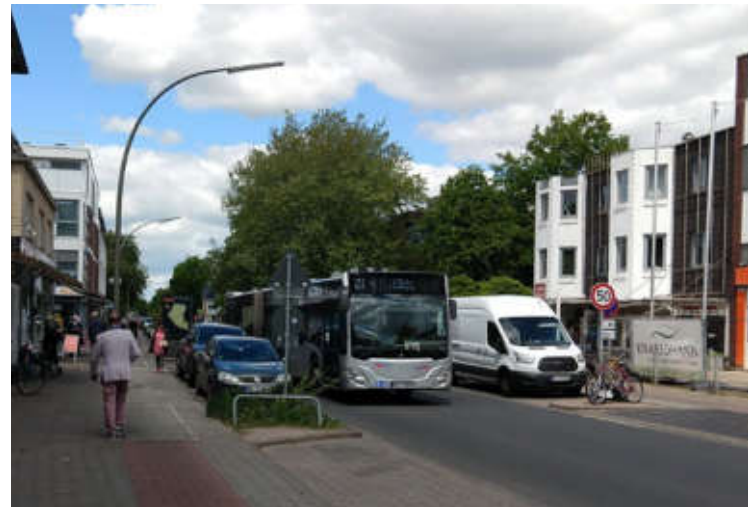
Abb. 29: Untermaßige Straßenverkehrsfläche in der Frohmestraße
