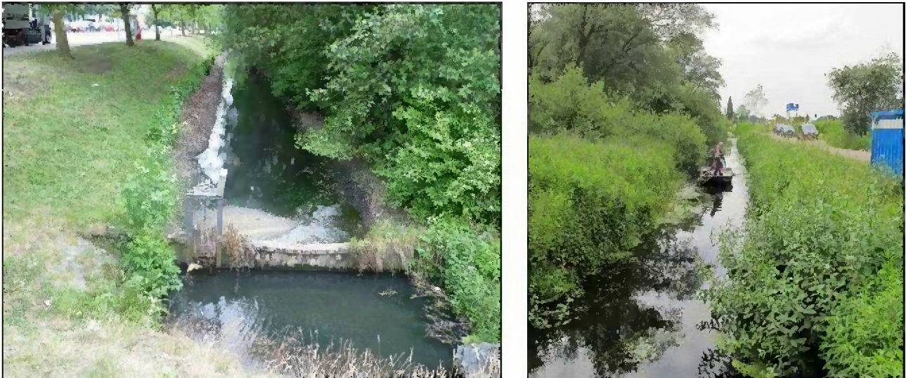
Abbildung 6: Wehr im Großmoorgraben (links) und Fünfhausener-Landweg-Wettern Höhe Neuländer See (rechts)
