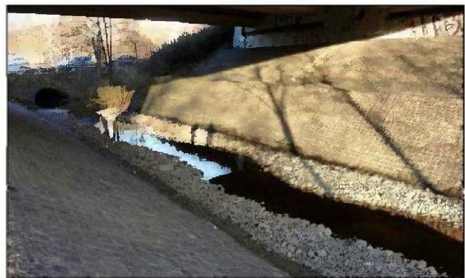
Abbildung 7: Totholz- und Kieseinbringung in der Neuländer Moorwettern unterhalb Stau 3.B
