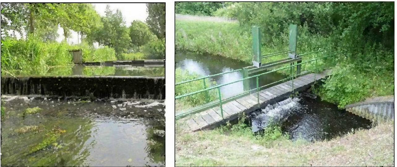
Abbildung 5: Sohlabsturz (links) und Wehr (rechts) in der Fünfhausener-Landweg-Wettern
