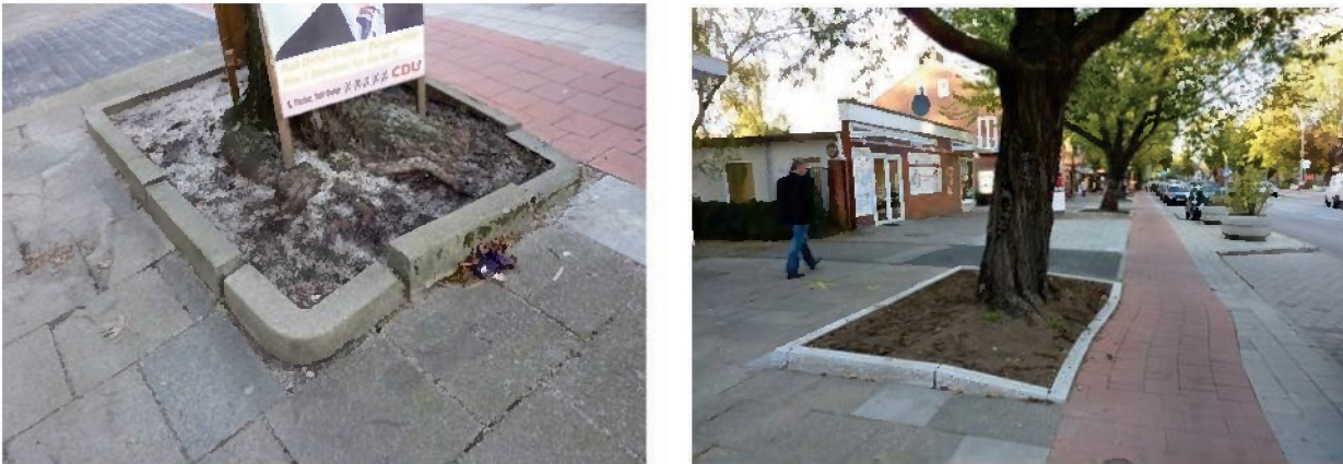
Abb. 16: Modernisierung und Vergrößerung der Baumscheiben: vorher und nachher (Quelle: steg Hamburg)
