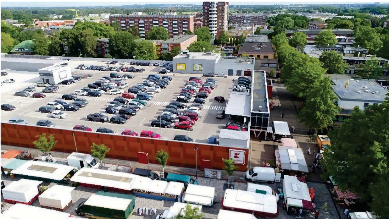
Abb. 2: Teilraum Zentrum mit der Marktfläche und Kaufland (Quelle: steg Hamburg)
