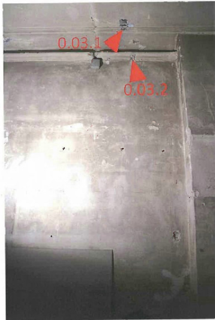
Übersicht der erfolgten Befundsnitte im Raum 0.03 des Erdgeschosses.
