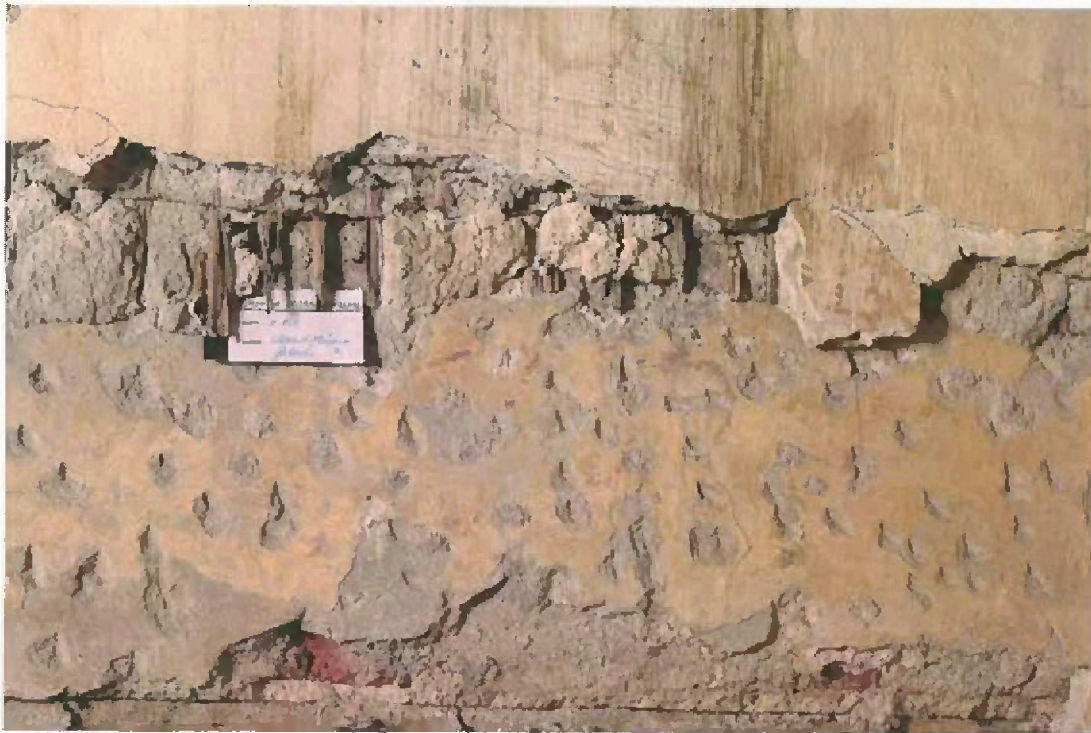
Detailaufnahme der Befundfläche mit roter Linienführung oberhalb des Riegels
