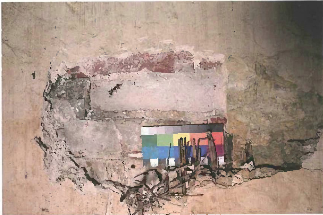
Fassungsabfolge auf dem Gedach der Wand a, Raum 1.01.
