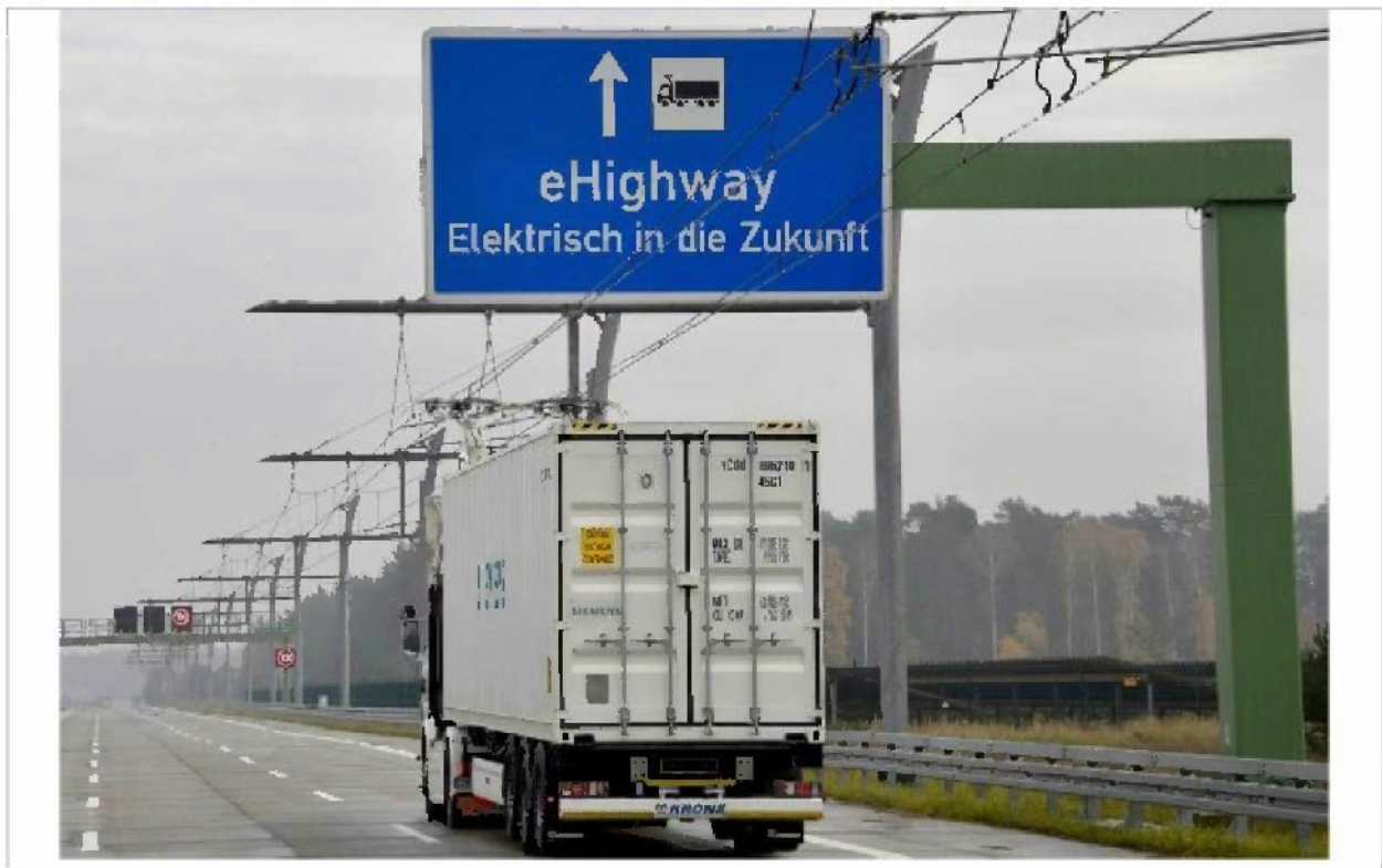
Abbildung 69 Teststrecke für elektrisch betriebene Lkw in Brandenburg
