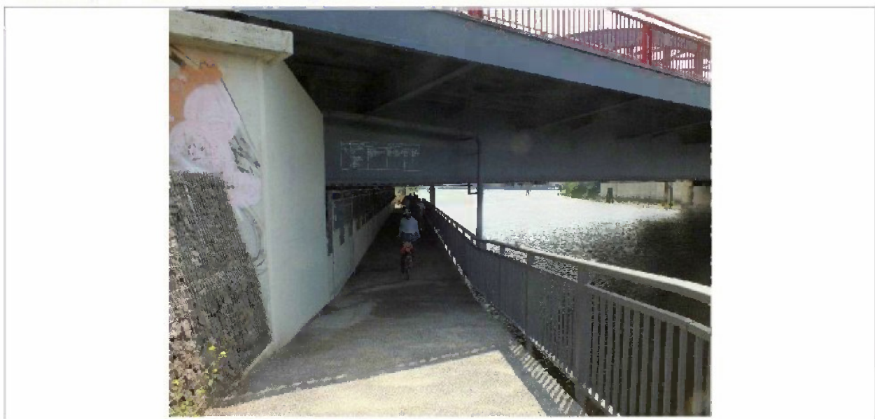
Abbildung 40 Fahrradunterführung Billhorner Brückenstraße
