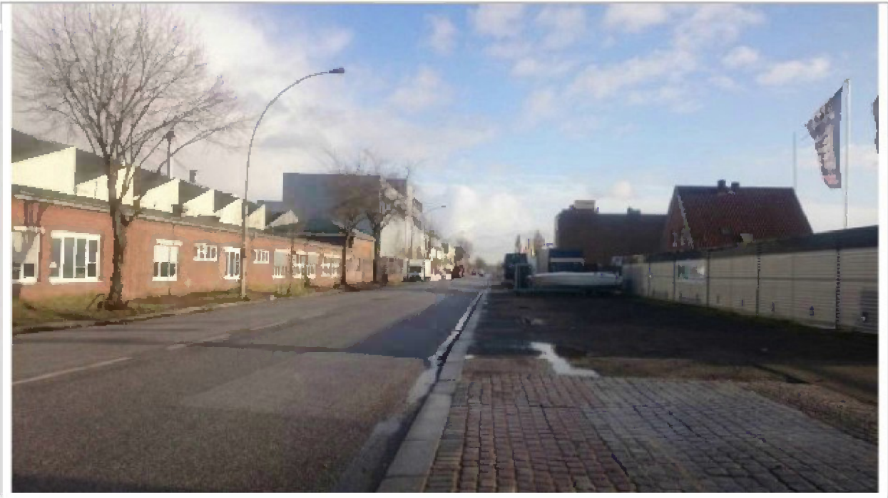
Abbildung 8 Fehlende Seitenräume für Fuß-/Radverkehr am Beispiel Liebigstraße
