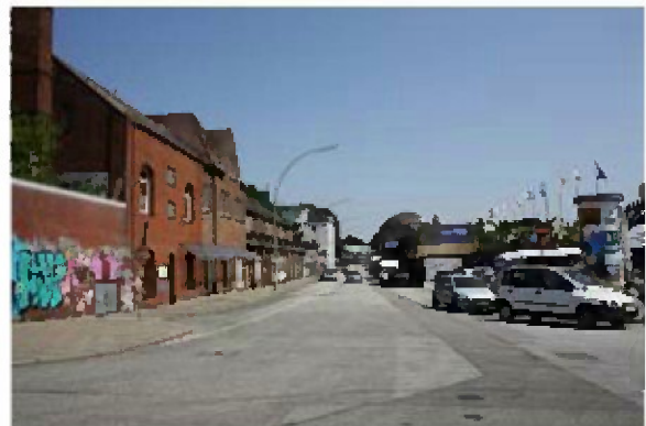
Ehem. Verwaltungsgebäude von Hamburg Wasser
