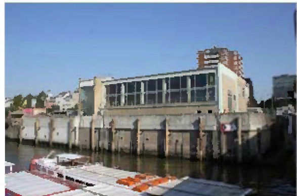
Pumpwerk von Hamburg Wasser
